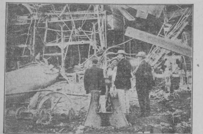
CENTRAL "ALAVA".—EL SEÑOR ENRIQUE ZULUETA Y EL INGENIERO INSPECTOR, VISITANDO EL LUGAR DE LA CATASTROFE. Foto grafía de José Sánchez Maldonado.
