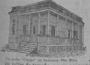
El ejército americano trajo consigo á Cuba la Techadura Congo y lo usa en sus barracas y establos. Resulta un techo impermeable muy duradero. Cualquiera lo puede colocar bien porque viene completamente listo para ello. La Techadura Congo se vende en rollos de tamaño y peso convenientes. Se desenrolla en el techo, cemento en las uniones y se clava—esto es todo. Se surten gratis el cemento y los clavos, etc.
