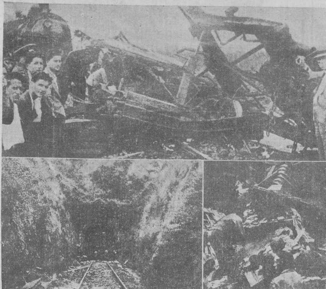
Tres notas de la catástrofe del expreso de Galicia. El material quedó completamente destrozado. Vista de la boca del túnel de Frada, donde se produjo el espantoso choque.
