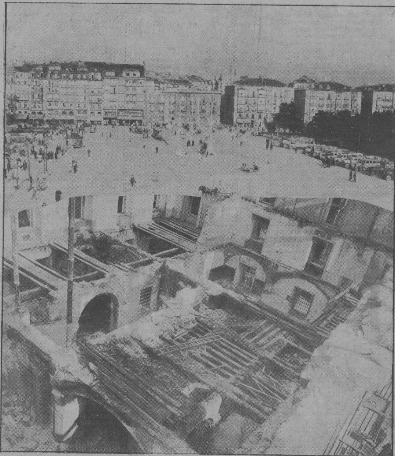
REFORMAS DE SANTANDER.—Estado en que se encuentran las obras de reforma que se efectúan en el viejo edificio de Aduanas, a cuya terminación embellecerá notablemente la gran Avenida de Galán y García Hernández. (F.º Alejandro).
