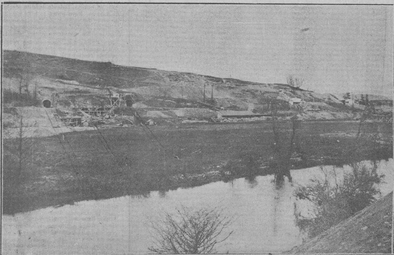
Una vista de las obras del pantano.—Las rayas que se advierten en el grabado señalan los imponentes túneles por donde el pantano ha de verter en el gran canal el agua que ha de llevar una nueva vida espléndida a las comarcas que atraviesa el Ebro.
