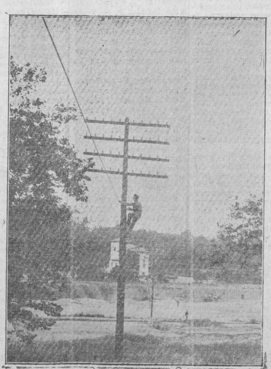
Operarios trepando a un poste para colocar los ganchos que soportan el cable bajo plomo, que se ve en la parte media
