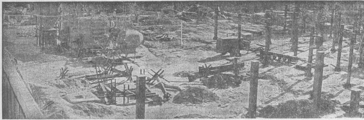
Estado actual de las obras de la nueva Cooperativa. (Foto BUSTAMANTE).
