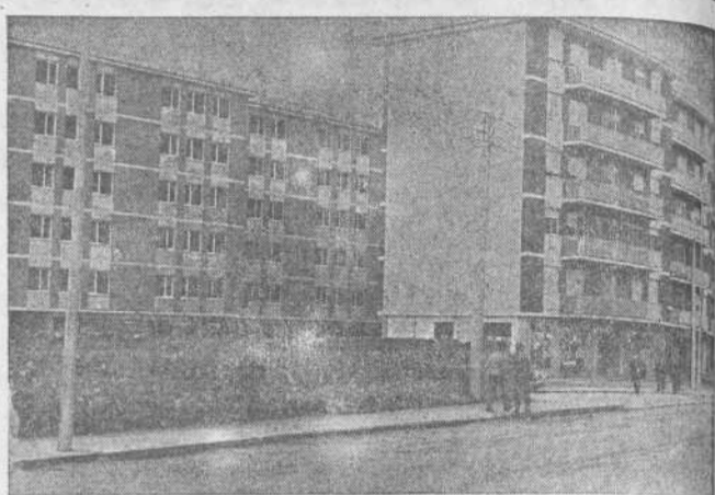
Grupo de viviendas construidas a lo largo del Paseo del General Dávila. En la foto de Manuel, un grupo frente a la calle de Antonio Mendoza, que destaca por sus amplias zonas verdes.
