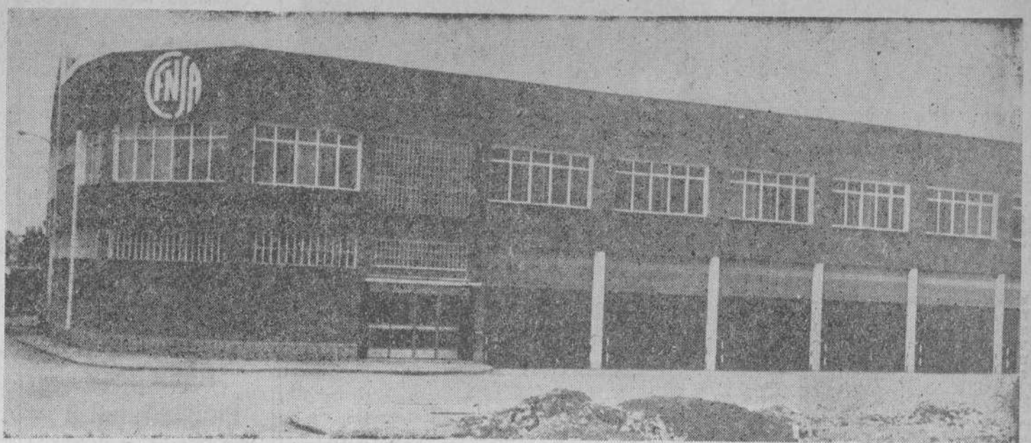
VISTA PARCIAL DE LA FACHADA PRINCIPAL DEL CENTRO FARMACEUTICO DEL NORTE, S. A. (Foto M. BUSTAMANTE).
