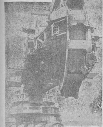
Las veces la longitud de un campo de fútbol y la altura de un rascacielos de veinte pisos tiene la más reciente curiosidad técnica que ofrece la industria productora de maquinaria alemana: una excavadora de rueda de cucharas que será empleada para la explotación del carbón vegetal en la cuenca lignífera de Renania, cerca de la capital de la República Federal de Alemania, Bonn.
