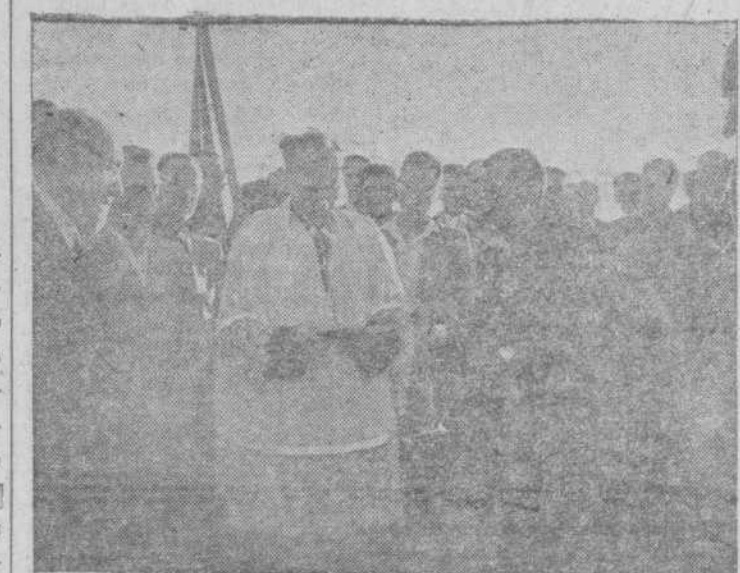
El doctor López de Castro, en el momento de bendecir las obras de riego de los huertos de Villoria. Al fondo, las autoridades. (Foto Guzmán Gombau.)
