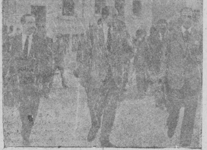
El alcalde de Madrid, señor Moreno Torres, durante su visita a la gran obra municipal que actualmente se realiza, recorre el bloque de viviendas para empleados que se construye en la Plaza de Manuel Becerra.
