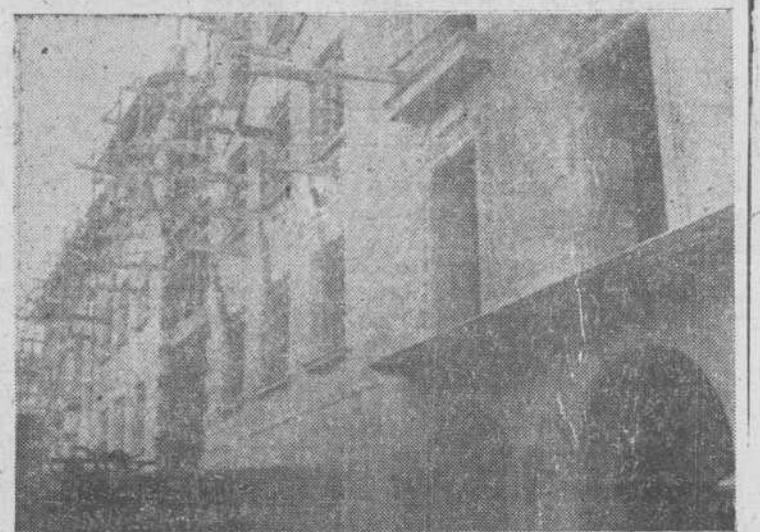
Estado actual de las obras de la nueva Casa Sindical
