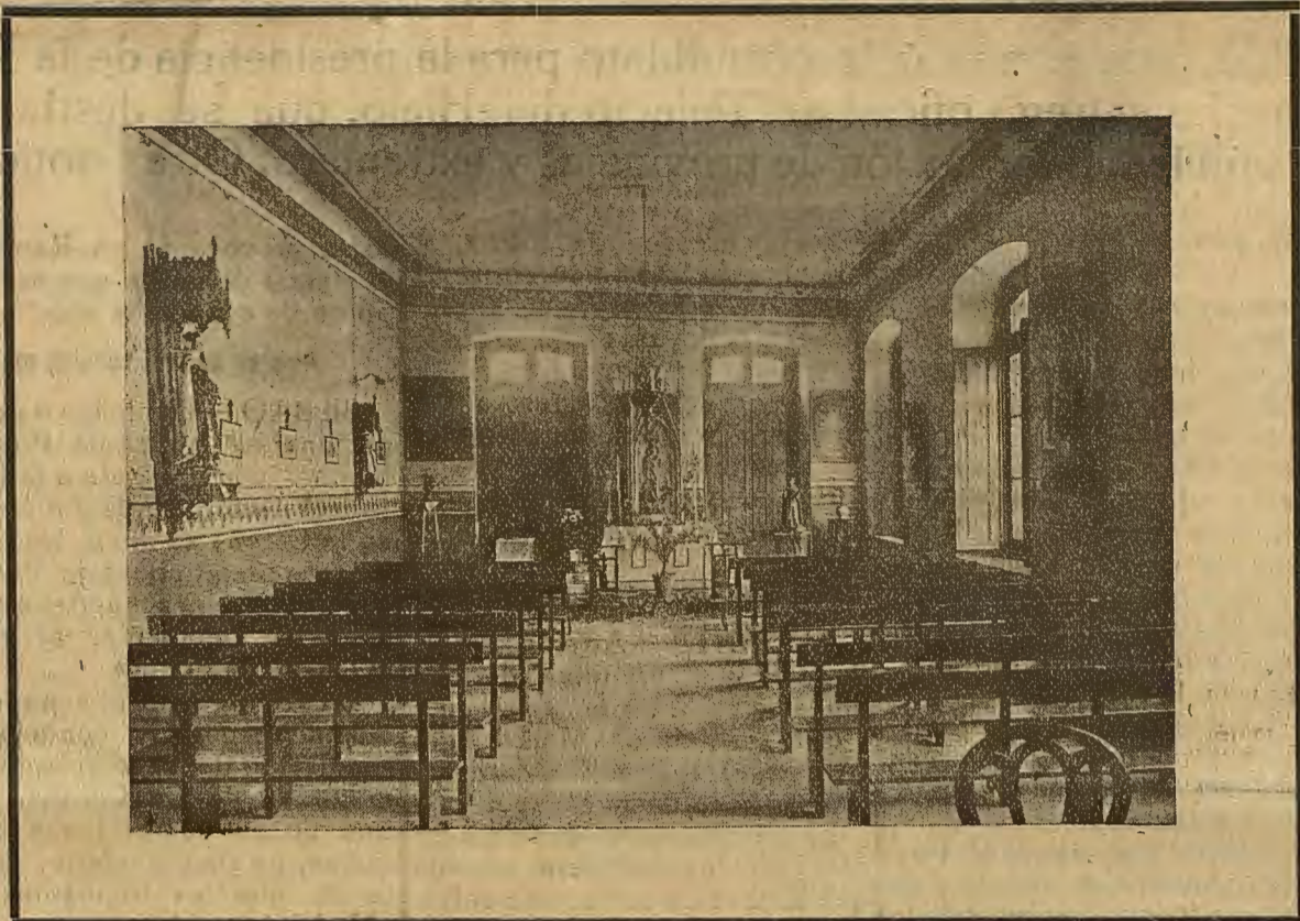
Convento y Colegio de Santa Rosa, con internado para señoritas CAPILLA
