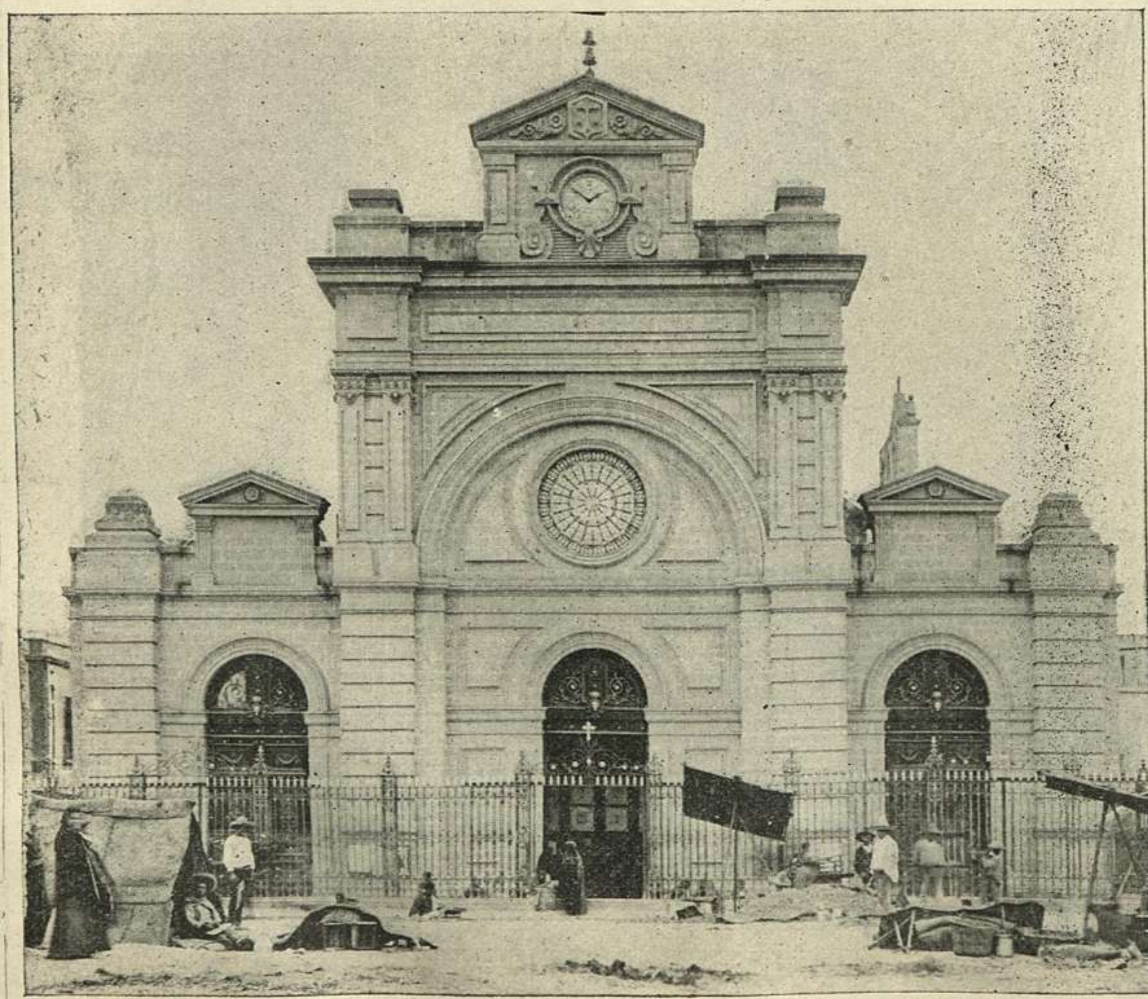
Fachada del Templo del Carmen
