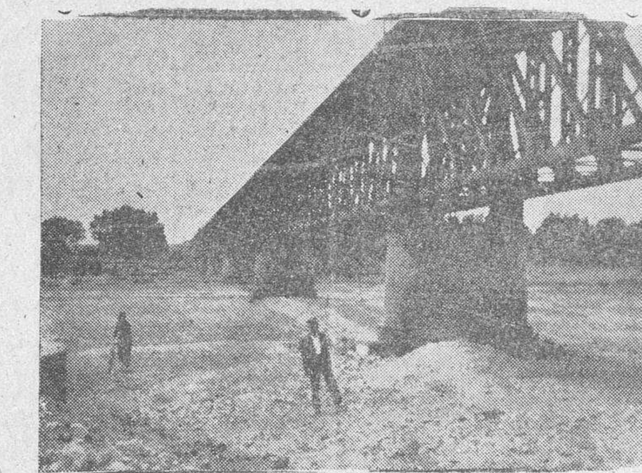
Desolador aspecto que presenta el Tormes en su cauce de «El Pradillo» (Foto J. Núñez.)
