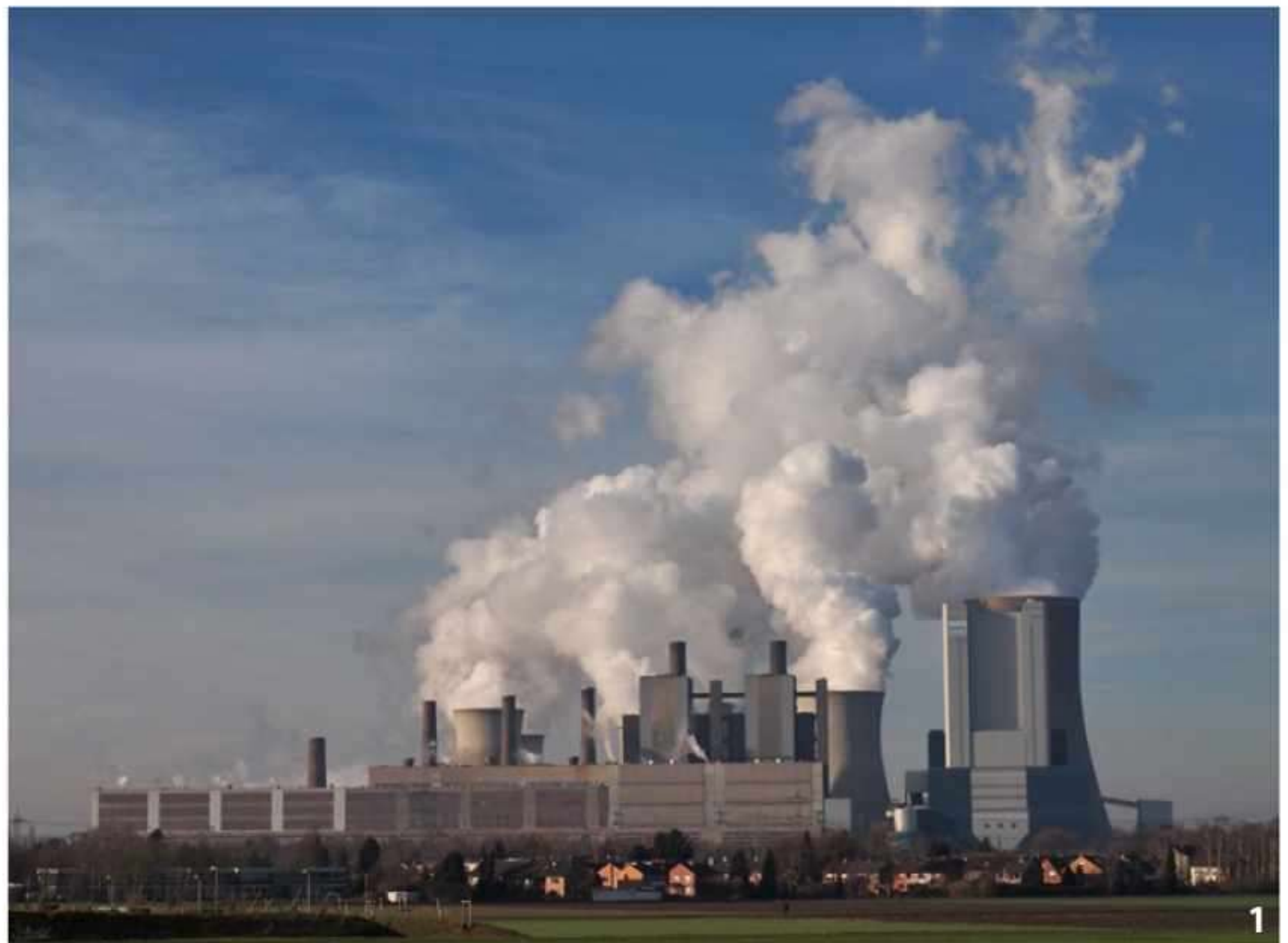
1. A pesar del aumento de las renovables, entre 2005 y 2015 se mantiene casi estable un elevado consumo de carbón en Alemania. Central termoeléctrica de carbón en Niederaussem. FOTO BY STODTMEISTER - OWN WORK, CC BY 3.0.
