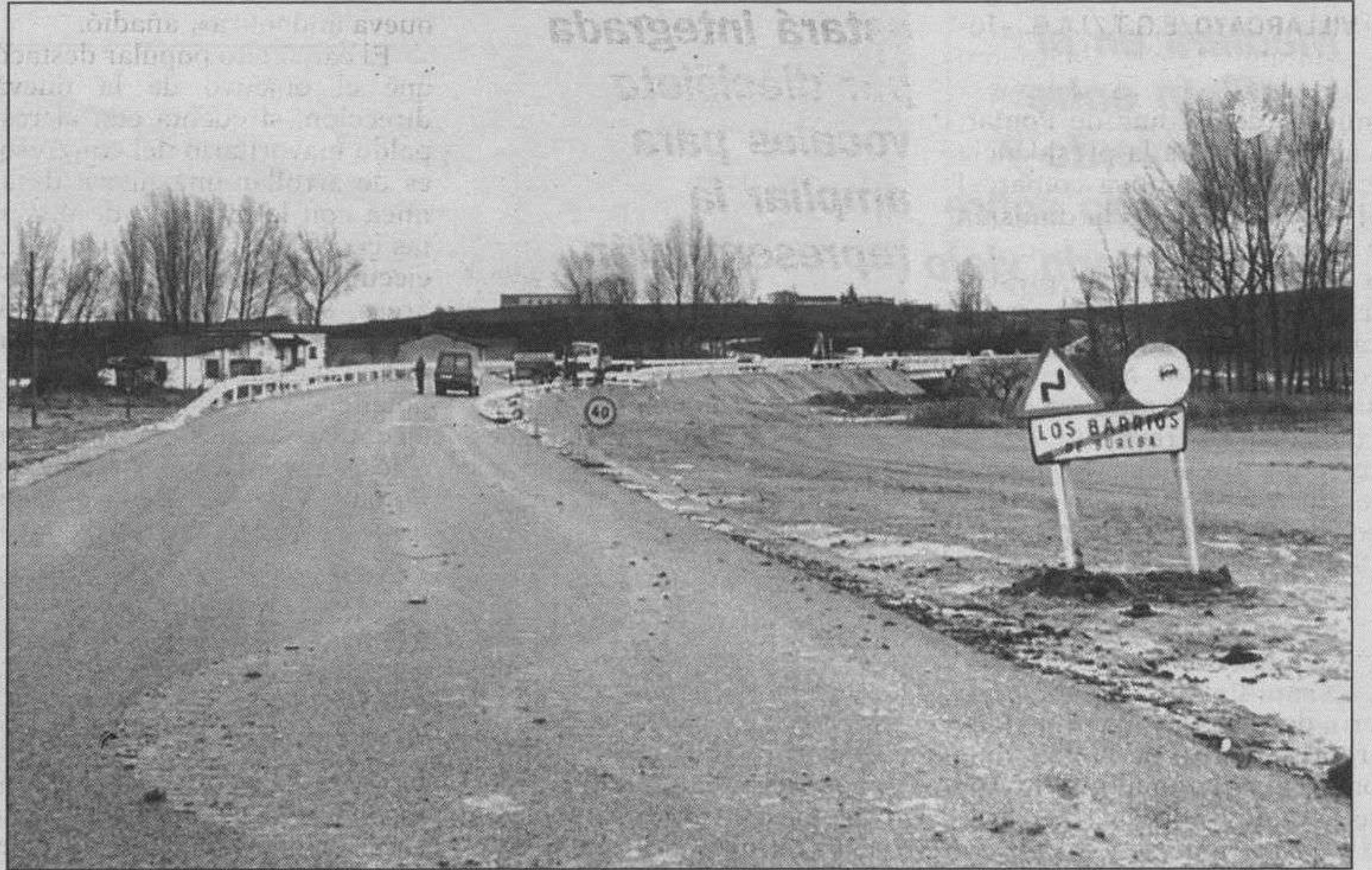
Las obras de la Junta en la carretera BU-510 concluyeron a finales del año pasado.
