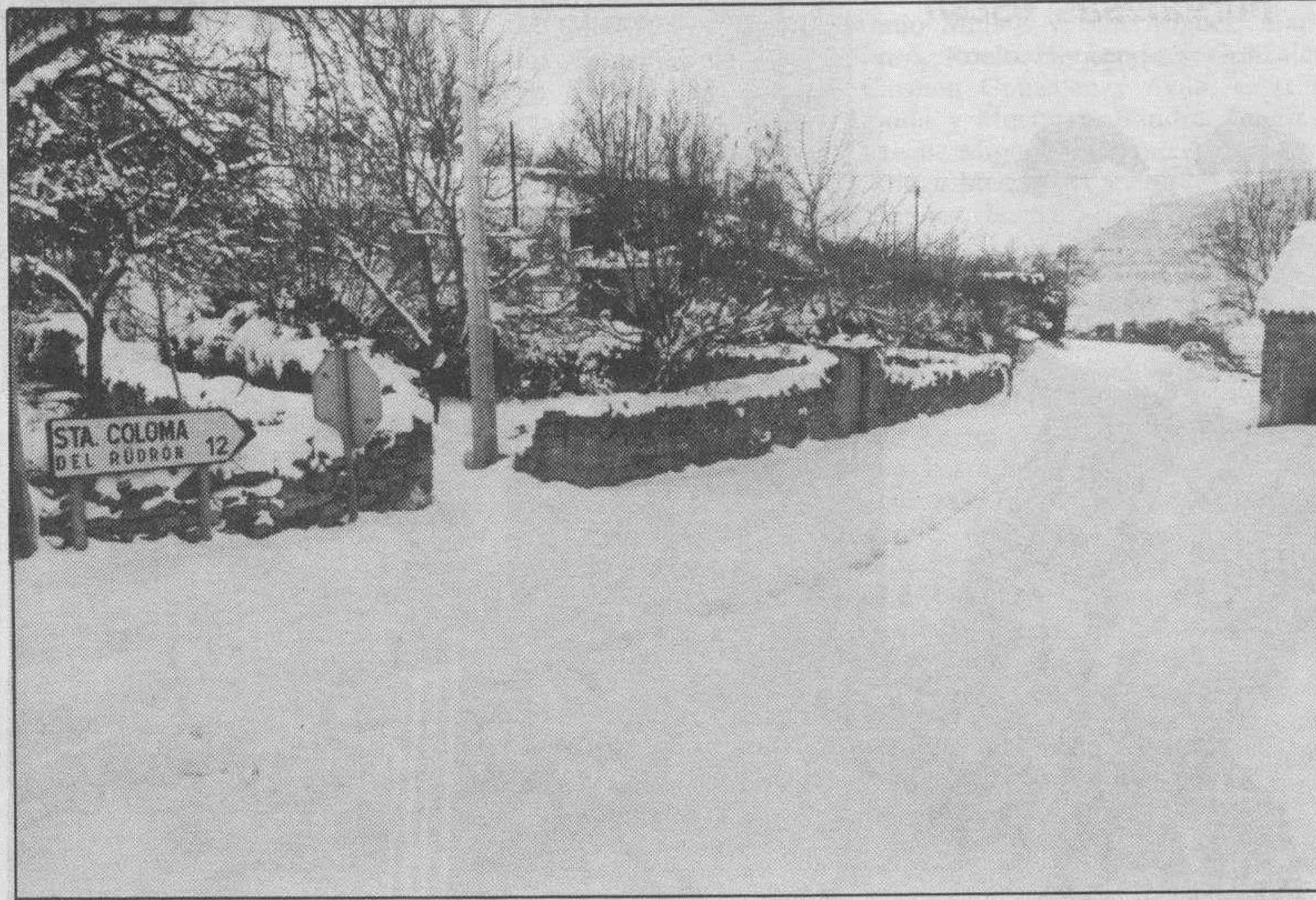
Numerosos tramos de carreteras se vieron cortados por la nieve caída y las bajas temperaturas.
