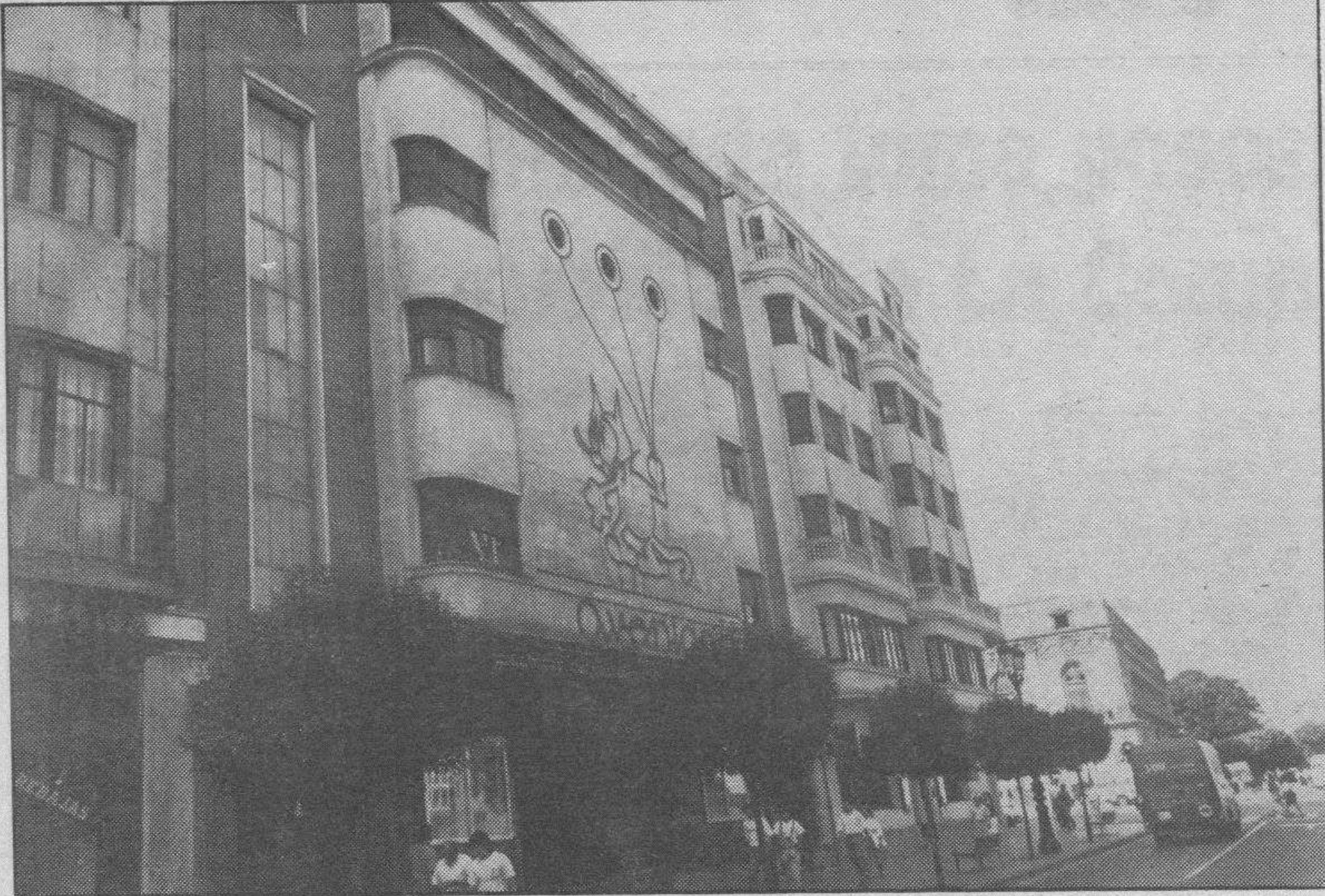
Esta fachada puede derribarse sin estar aprobado por Patrimonio.
