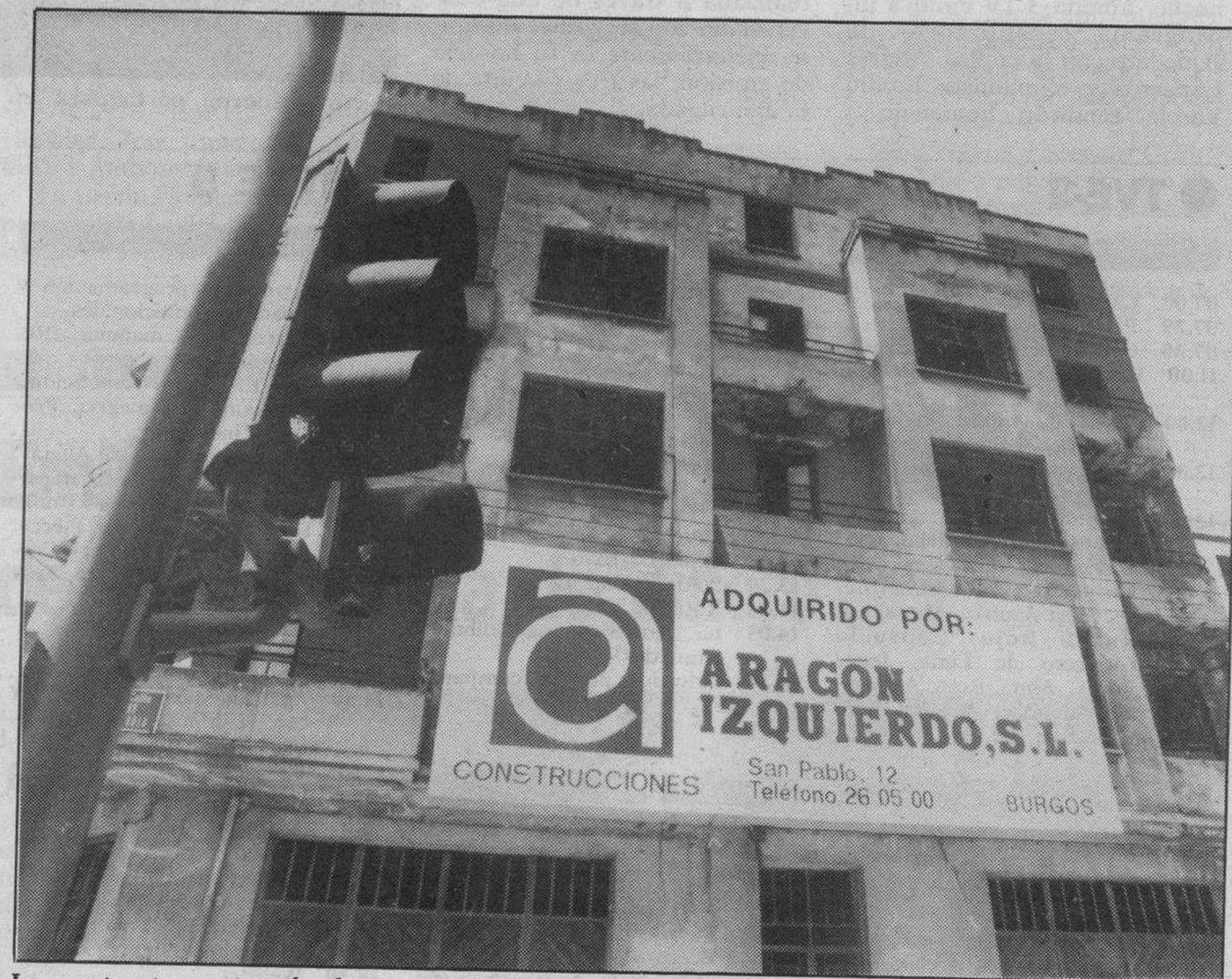
La constructora espera la «luz verde» del Ayuntamiento. (Foto: Luis López Araico)
