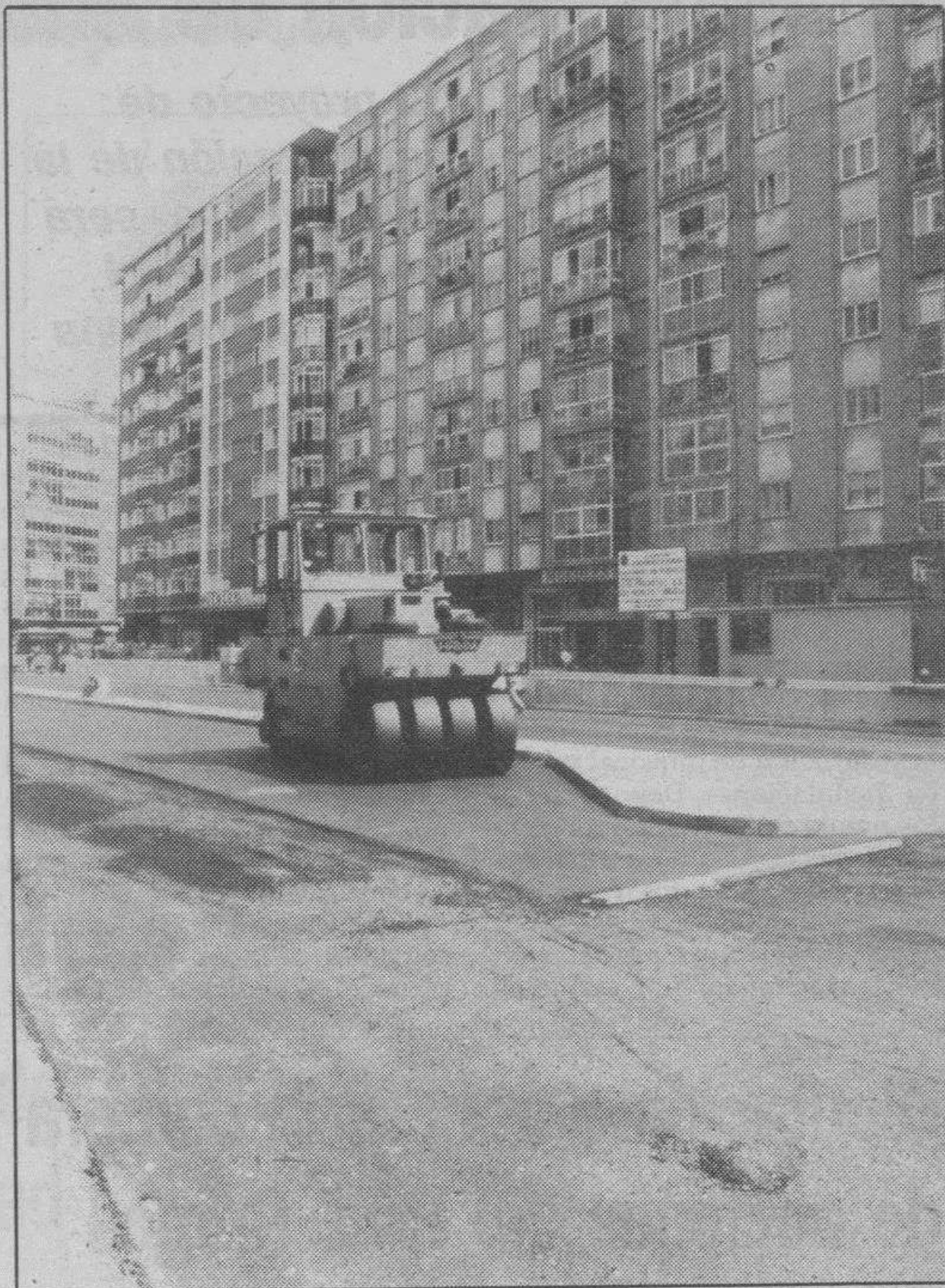
En la mañana acabaron las labores de asfaltado. (Foto: A. Rodrigo)
