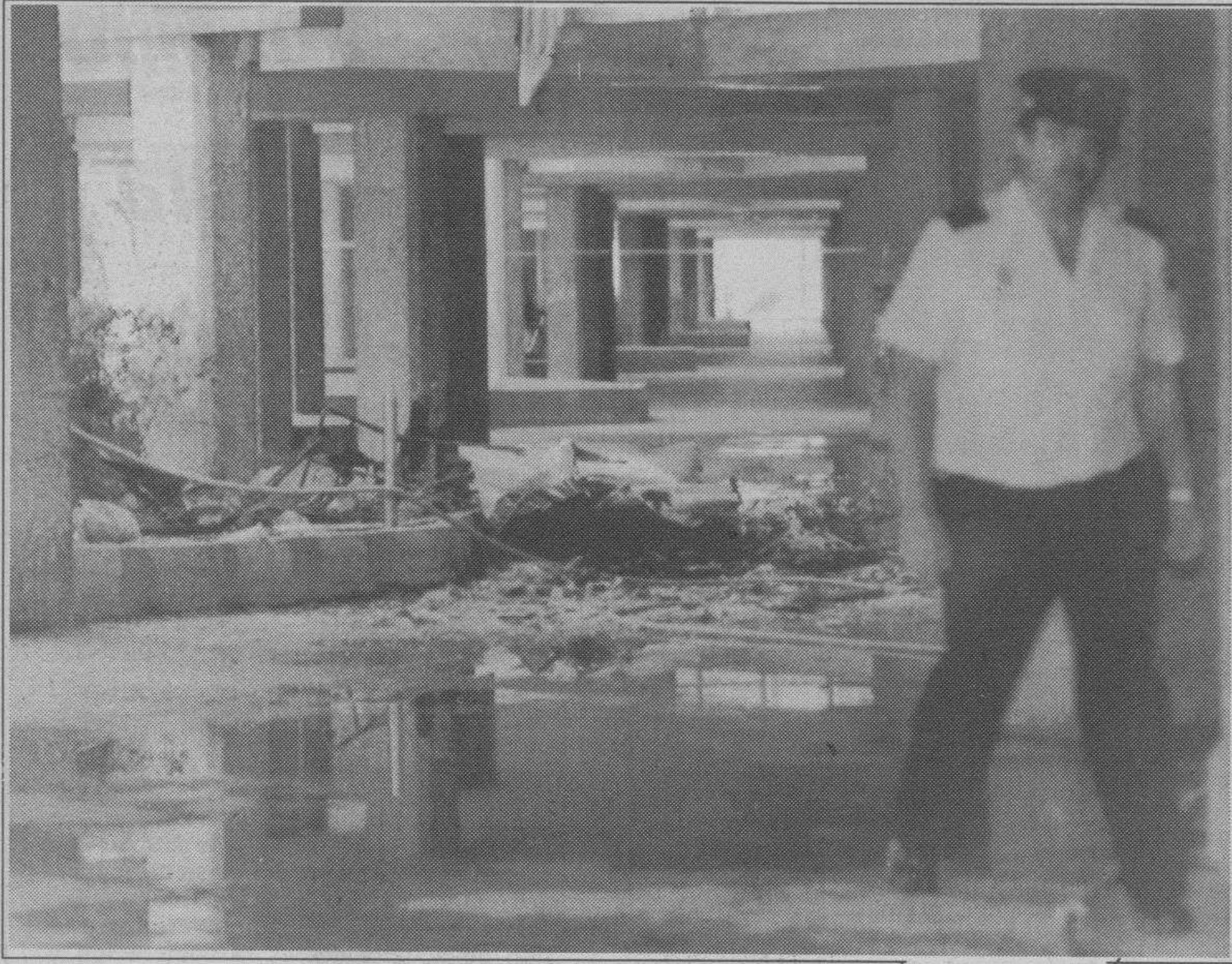
MOSTOLES.- «Doce muertos». Escombros, ropas y agua, son los restos del incendio que se produjo el martes en el edificio de la calle Hermanos Pinzón de Mostoles, donde doce personas, nueve de ellos polacos, perdieron la vida. Fue la tragedia de la semana. (Foto: Efe).
