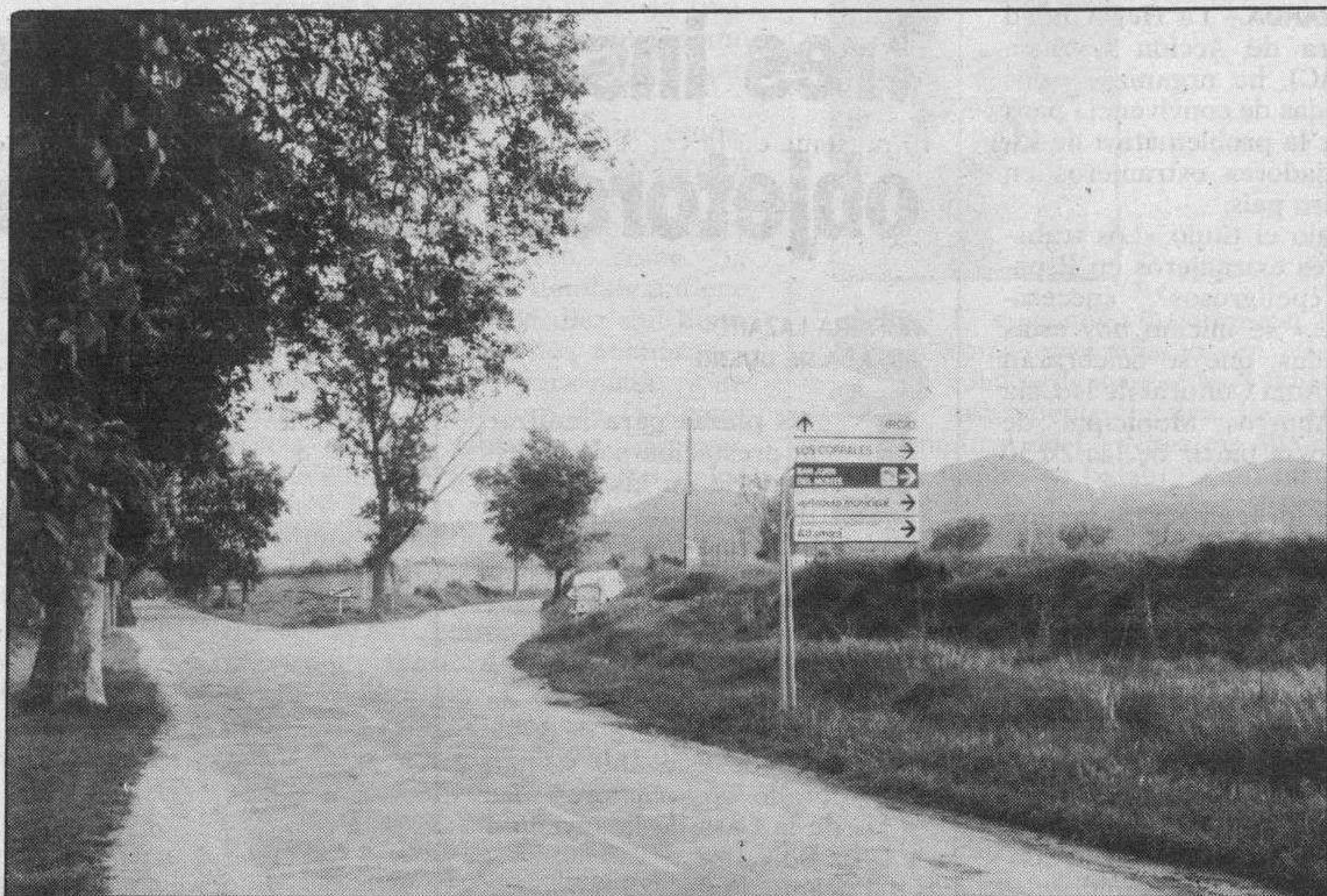
La zona a mejorar tiene una longitud de algo más de tres kilómetros. (Foto: Truchuelo).
