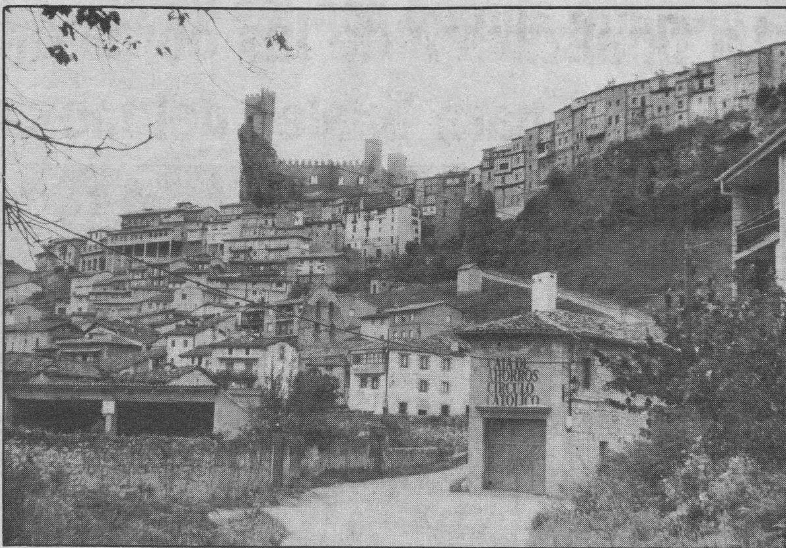
Las grietas en las rocas de las casas colgantes preocupan a los vecinos. (Foto: DB)
