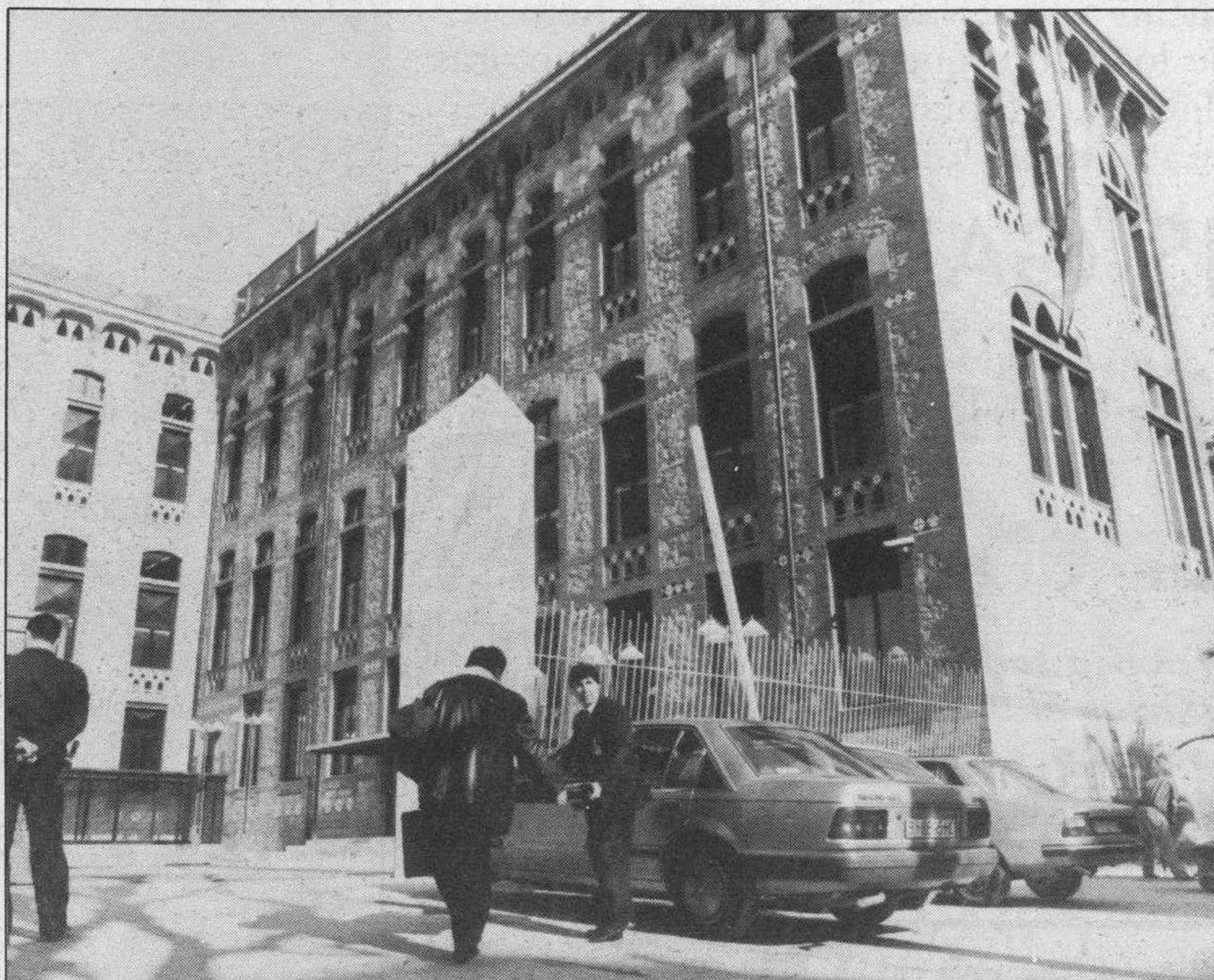
Sede del COOB, ubicada en la antigua «Maternitat de les Corts». (Foto: Efe).
