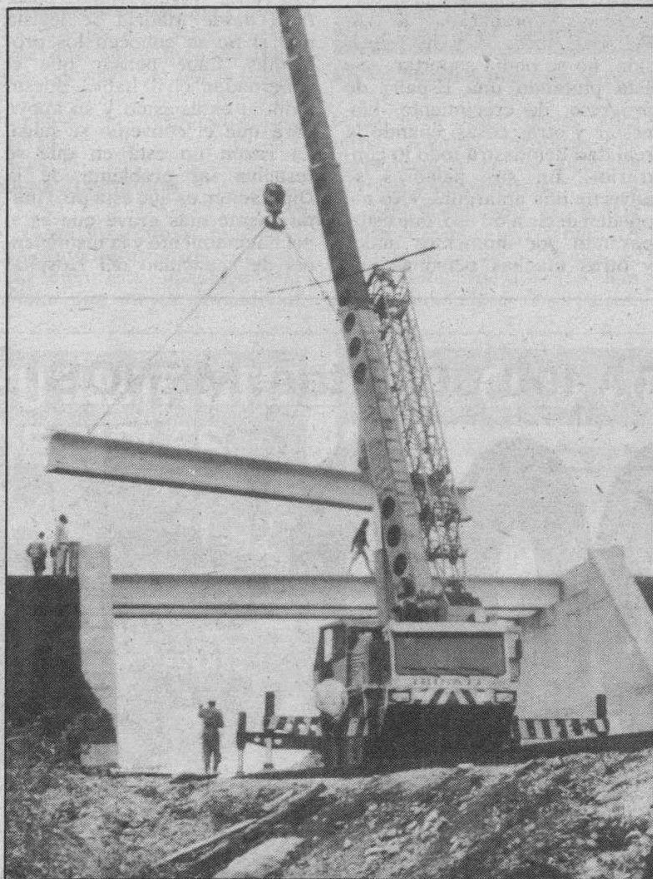
Uno de los pasos elevados construidos.
