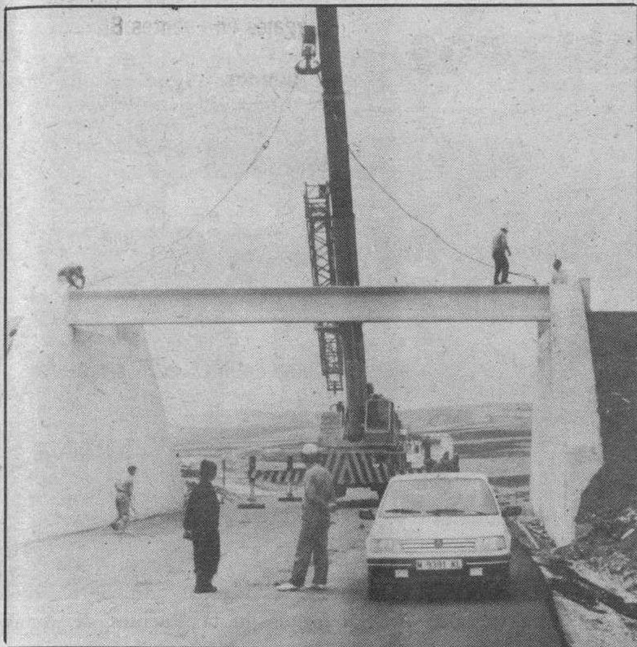
Imagen de un puente elevado para tránsito de maquinaria agrícola.
