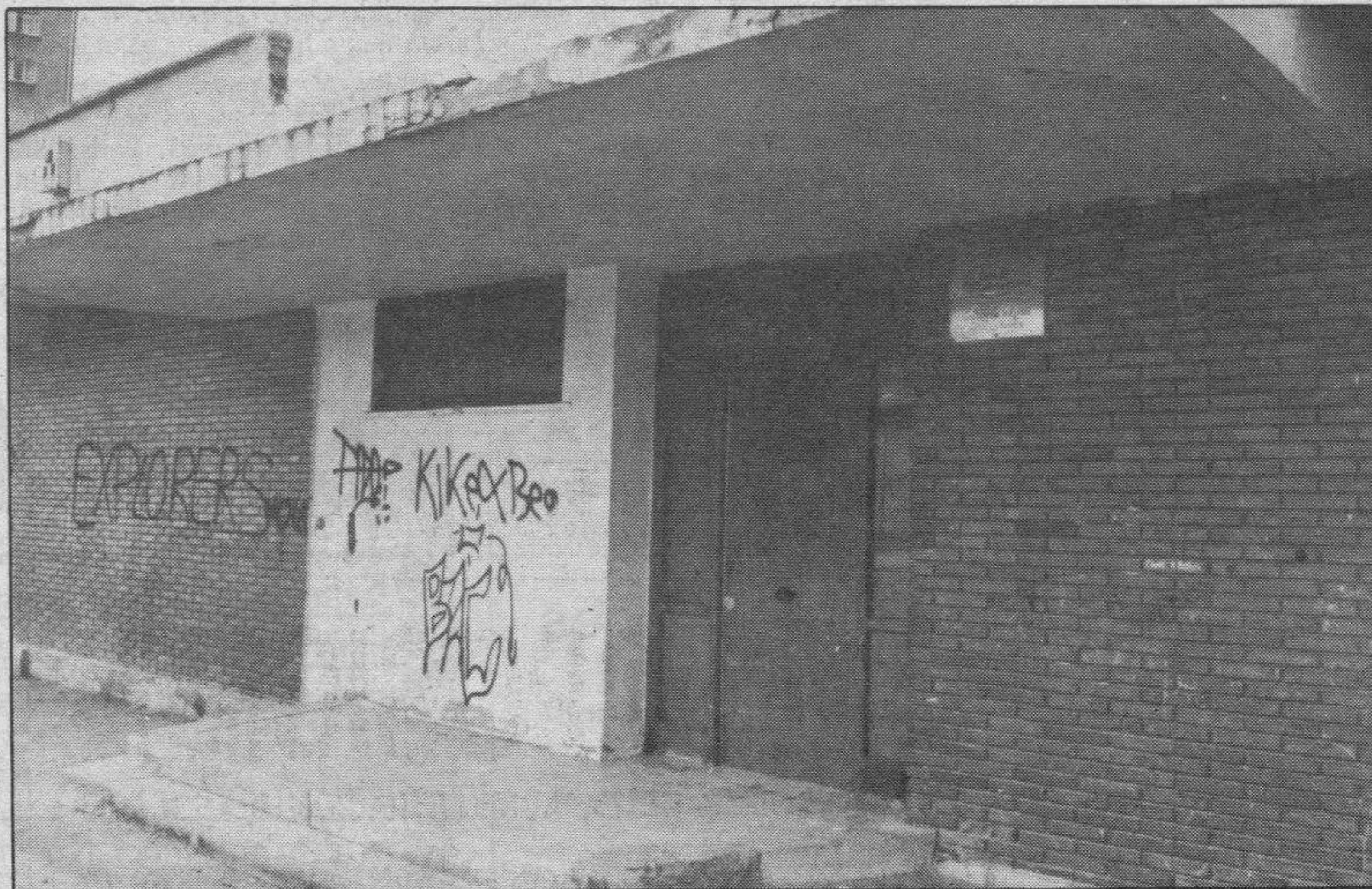
Aspecto de la fachada de la guardería infantil «Santa María La Mayor». (Foto: L. López Araico).
