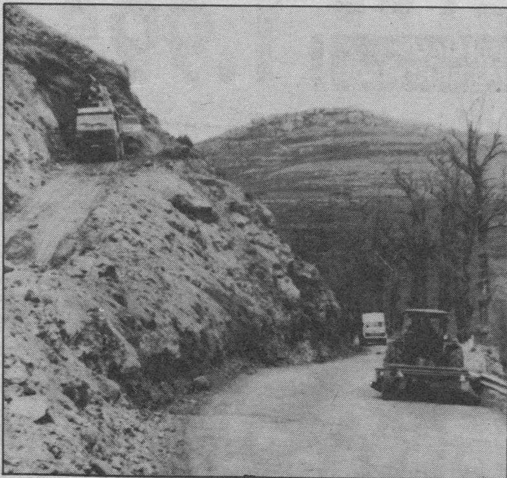
Vista de los desmontes realizados en el tramo de Tubilla.
