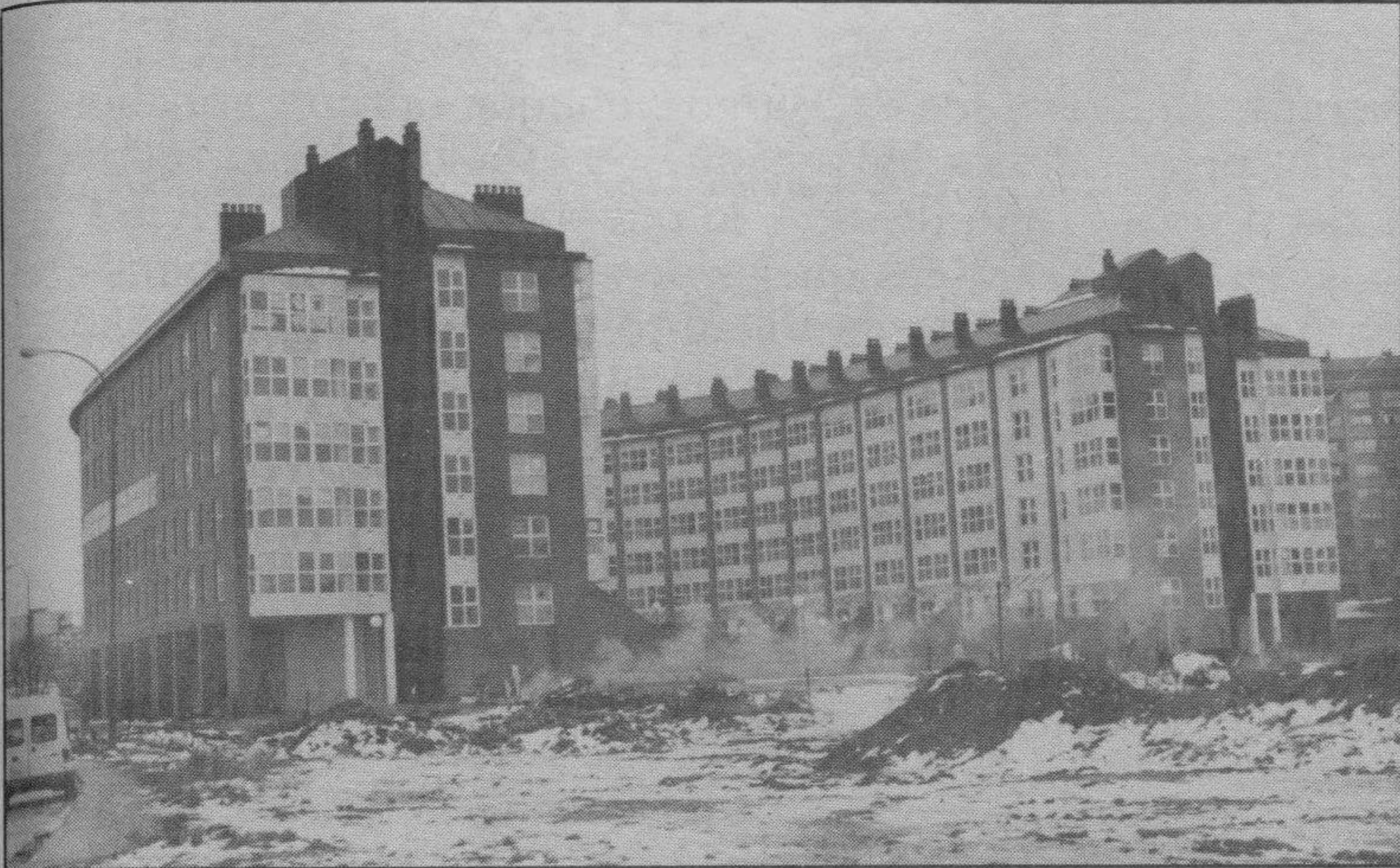
Según los técnicos municipales, este edificio de «Luis Labín» tiene exceso de edificabilidad
