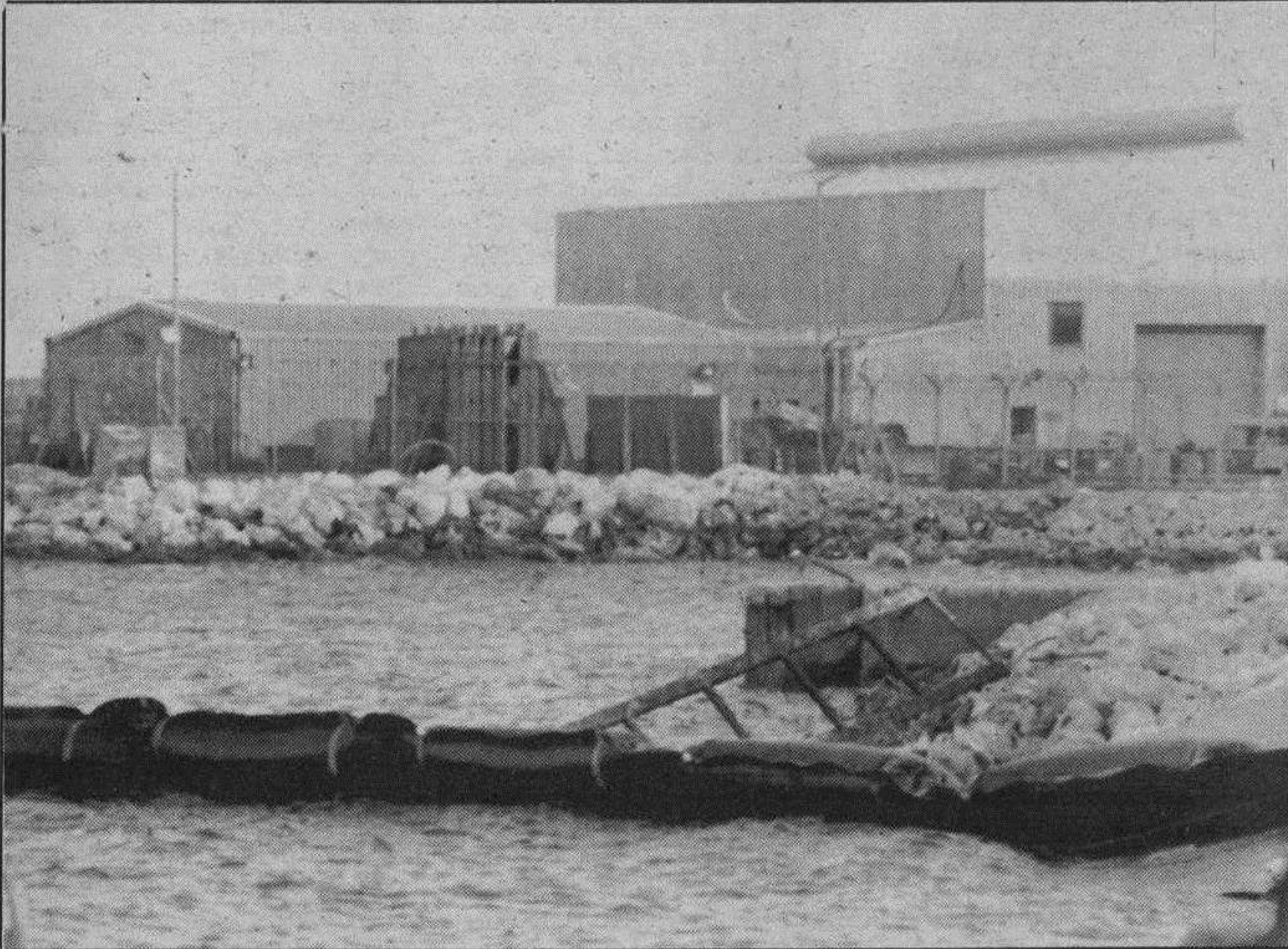
La estación de bombeo de Manama (Kuwait) ha sido parada. AP/Efe
