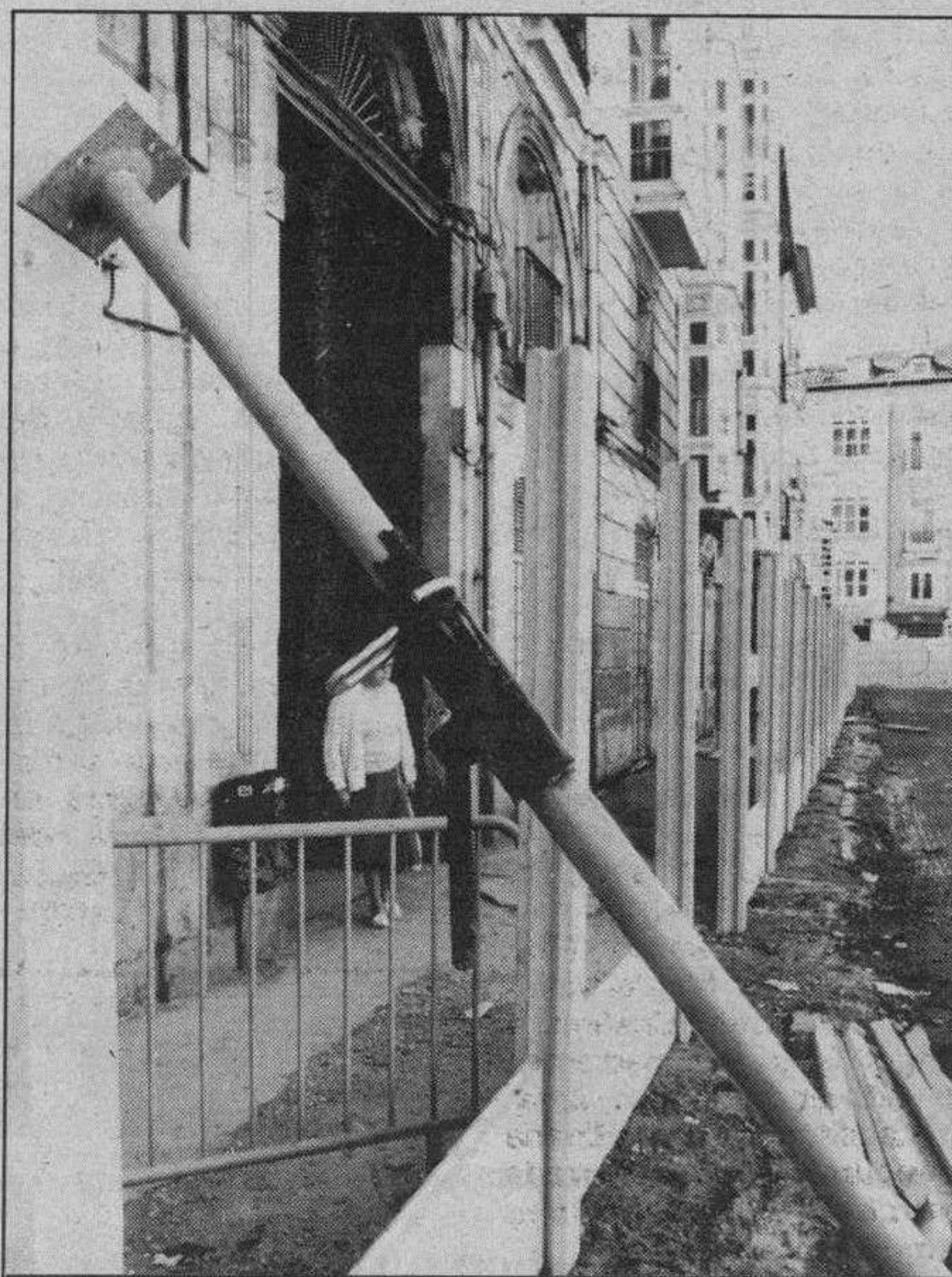
Aparcamiento de La Flora en construcción. F. Archivo
