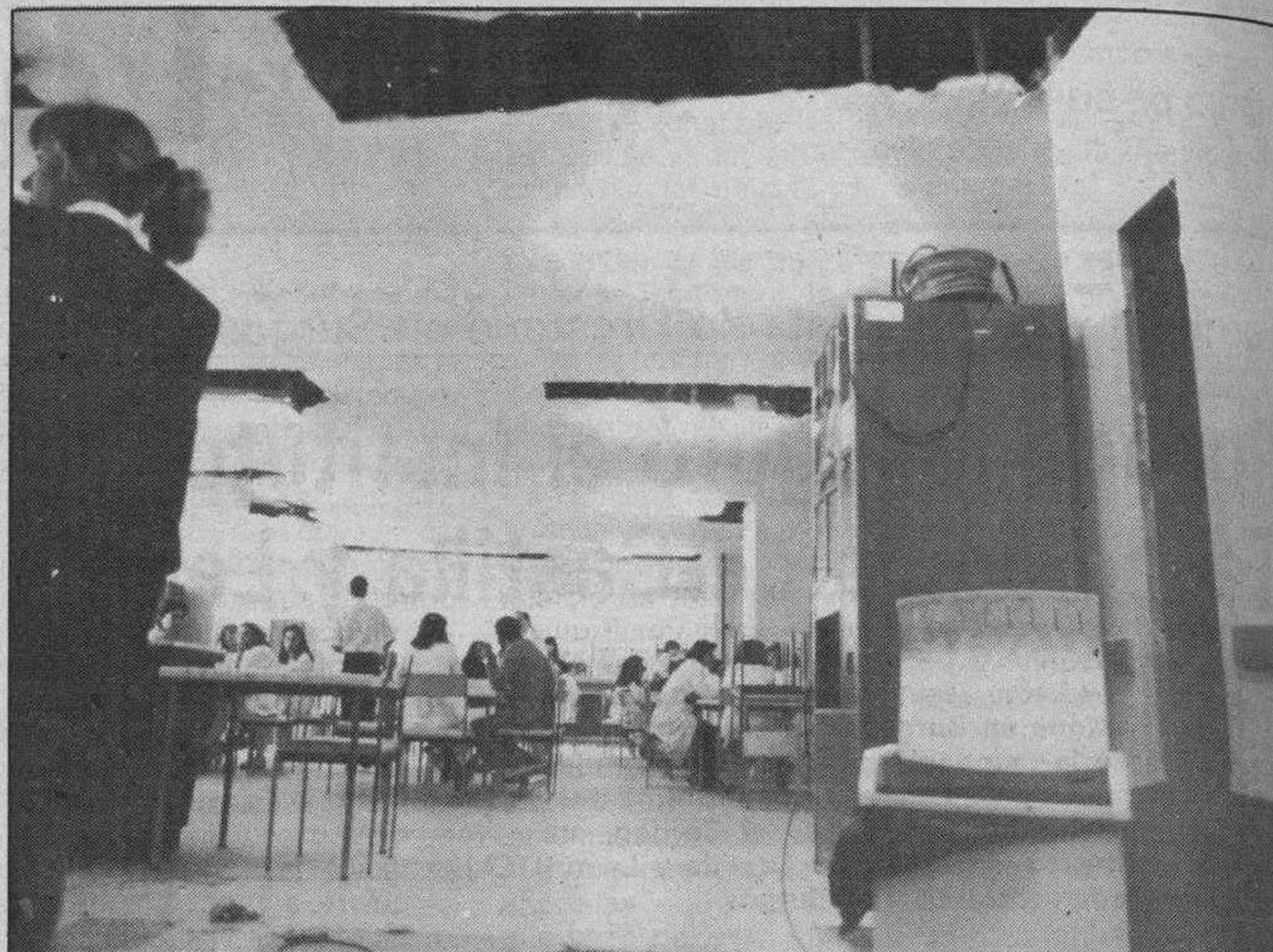
Las numerosas y continuadas obras en el Hospital General Yagüe repercuten en una situación de permanente incomodidad y riesgo. (Foto L. Matías)
