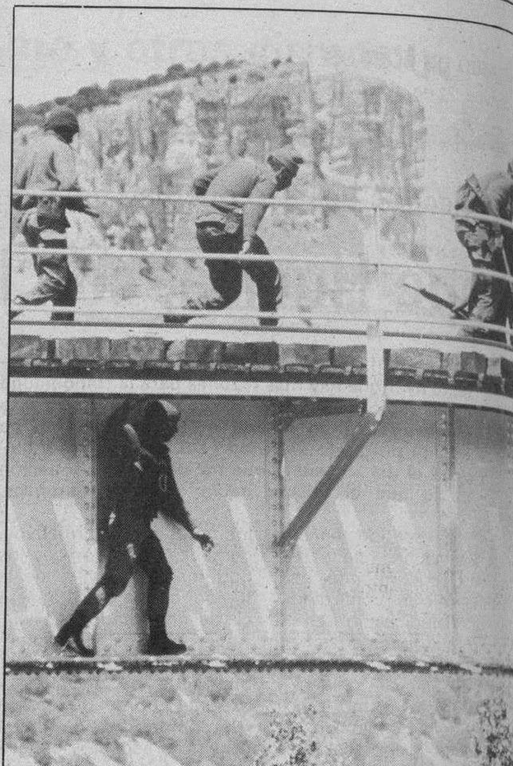
Comandos colocando las cargas para la voladura simulada de un puente sobre el ferrocarril. Foto Alberto Rodrigo.
