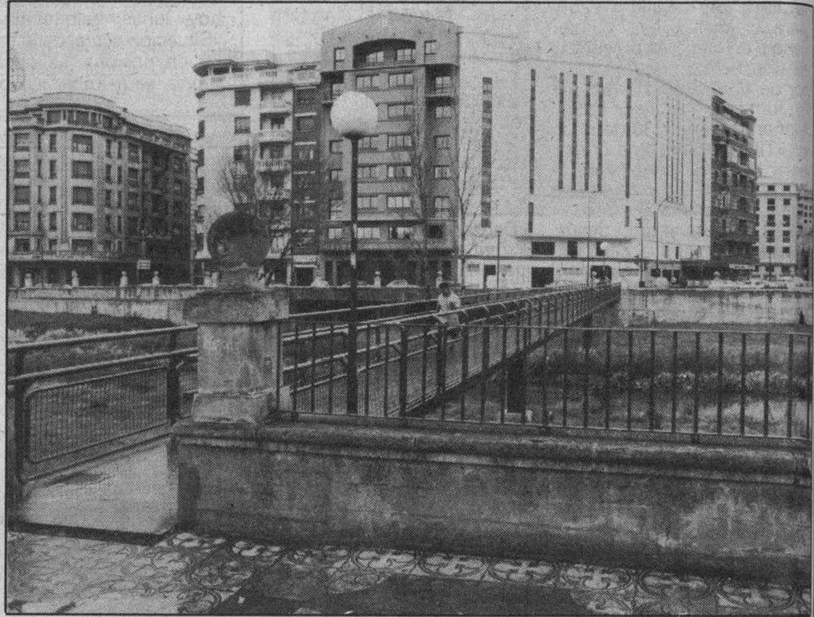
Esta pasarela peatonal, entre Conde de Vallellano y Conde Jordana, se transformará en puente para circulación de vehículos
