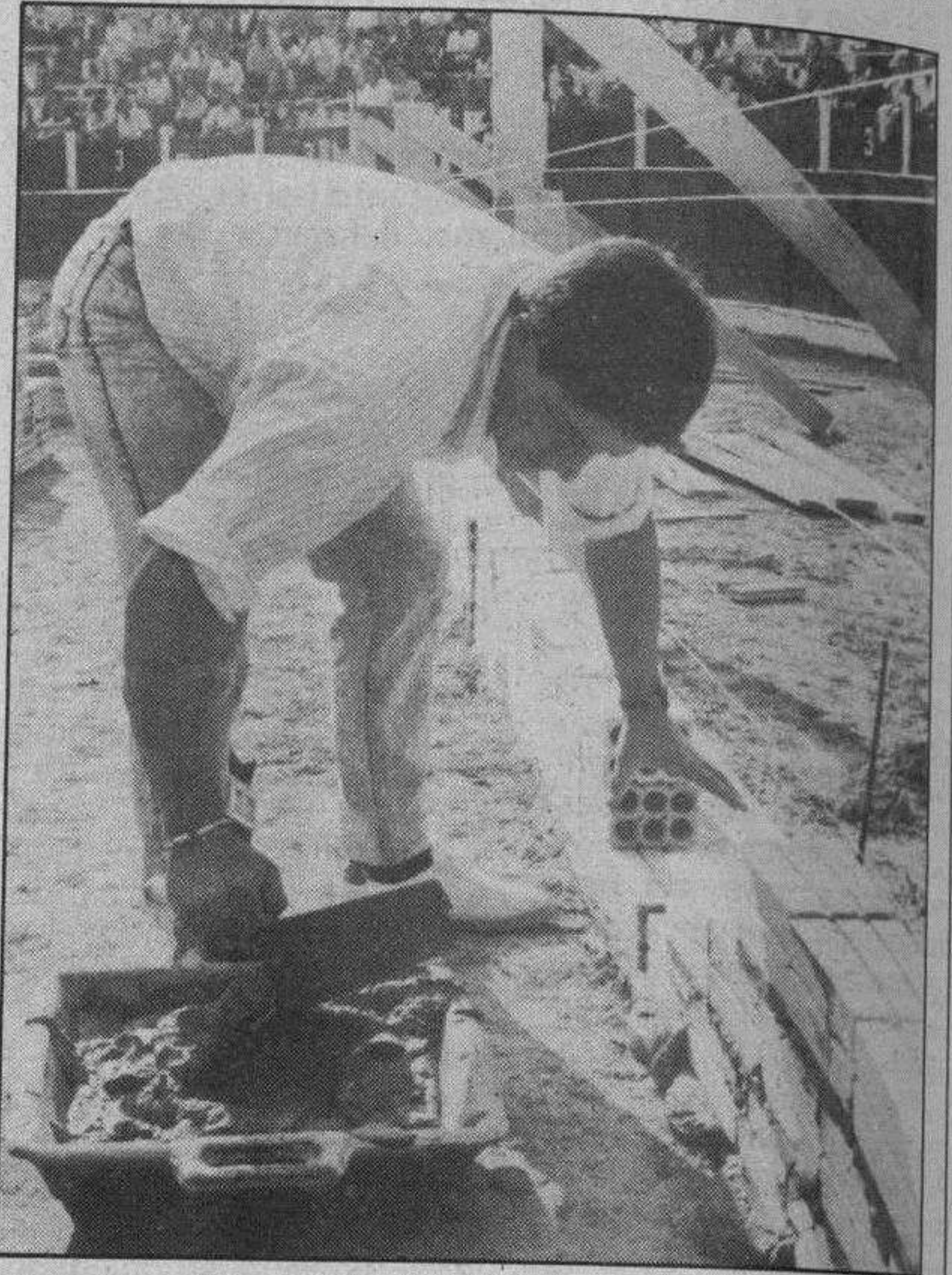
El burebano, que acaba de batir el record de colocación de ladrillos, ha tratado en su acto de mostrar que su profesión es tan digna como cualquier otra. Foto archivo.
