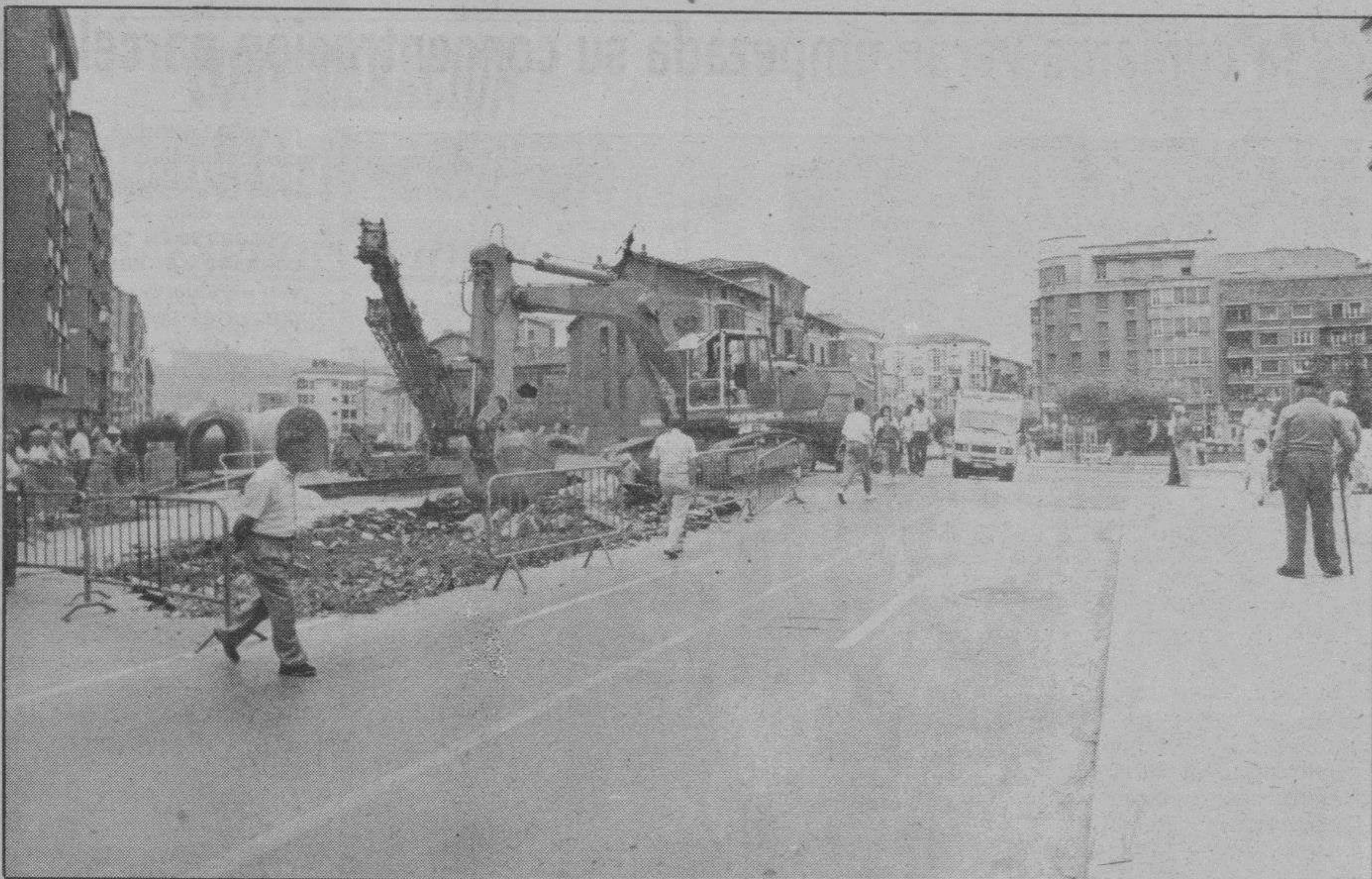
Uno de los tramos más complejos de la Ronda ya está en marcha. La calle de La Estación. Las obras han comenzado y se pretende restablecer la circulación para el mes de Septiembre.
