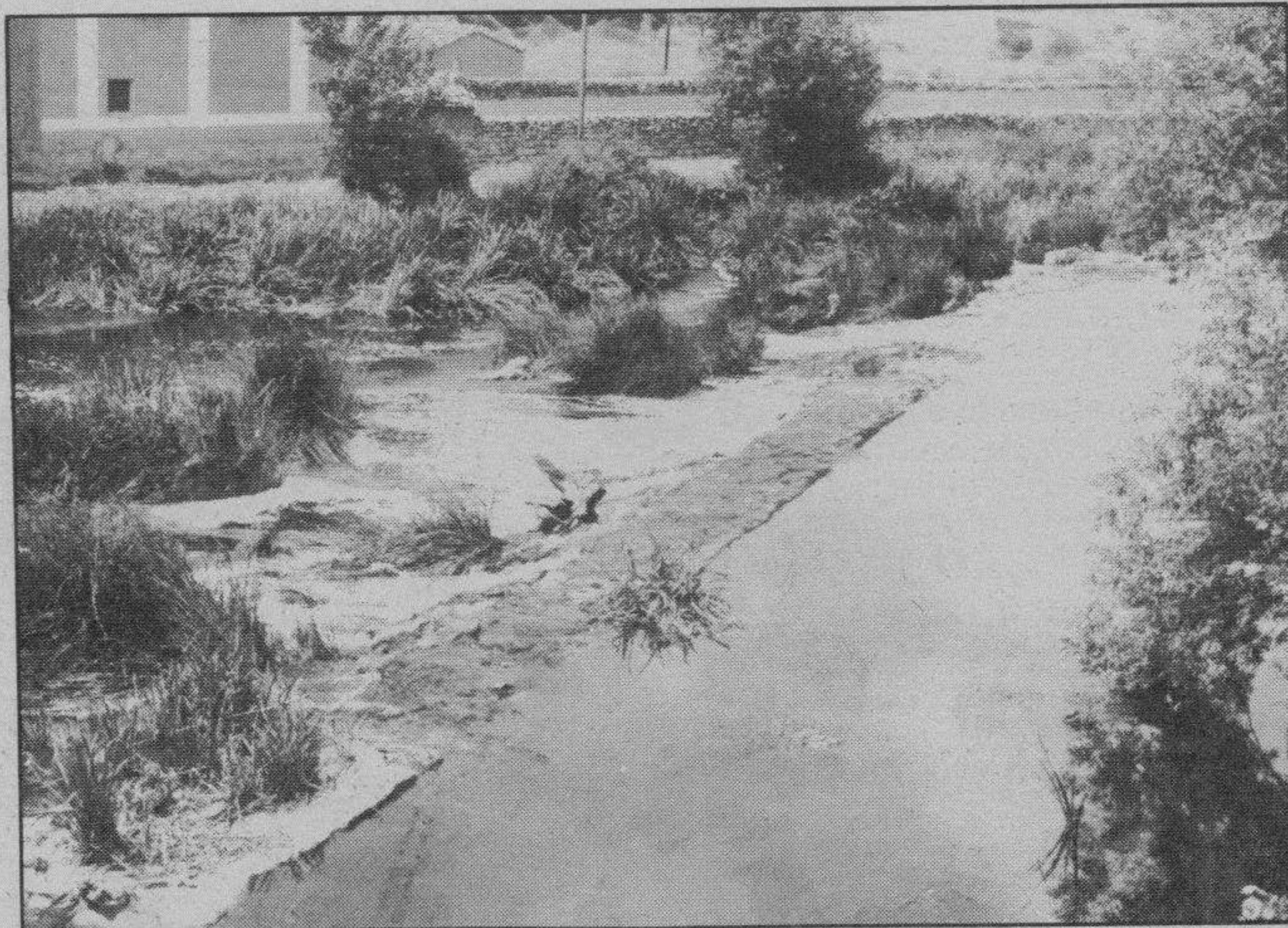
Hubo algún fallo en la depuradora. — Las quejas y protestas de algunos vecinos de municipios de la vega baja del Arlanzón por la contaminación del Arlanzón estaban justificadas en algún fallo en el funcionamiento de la estación depuradora de aguas de Villalonquén que pese a los días transcurridos, todavía no se ha explicado pública y oficialmente.
