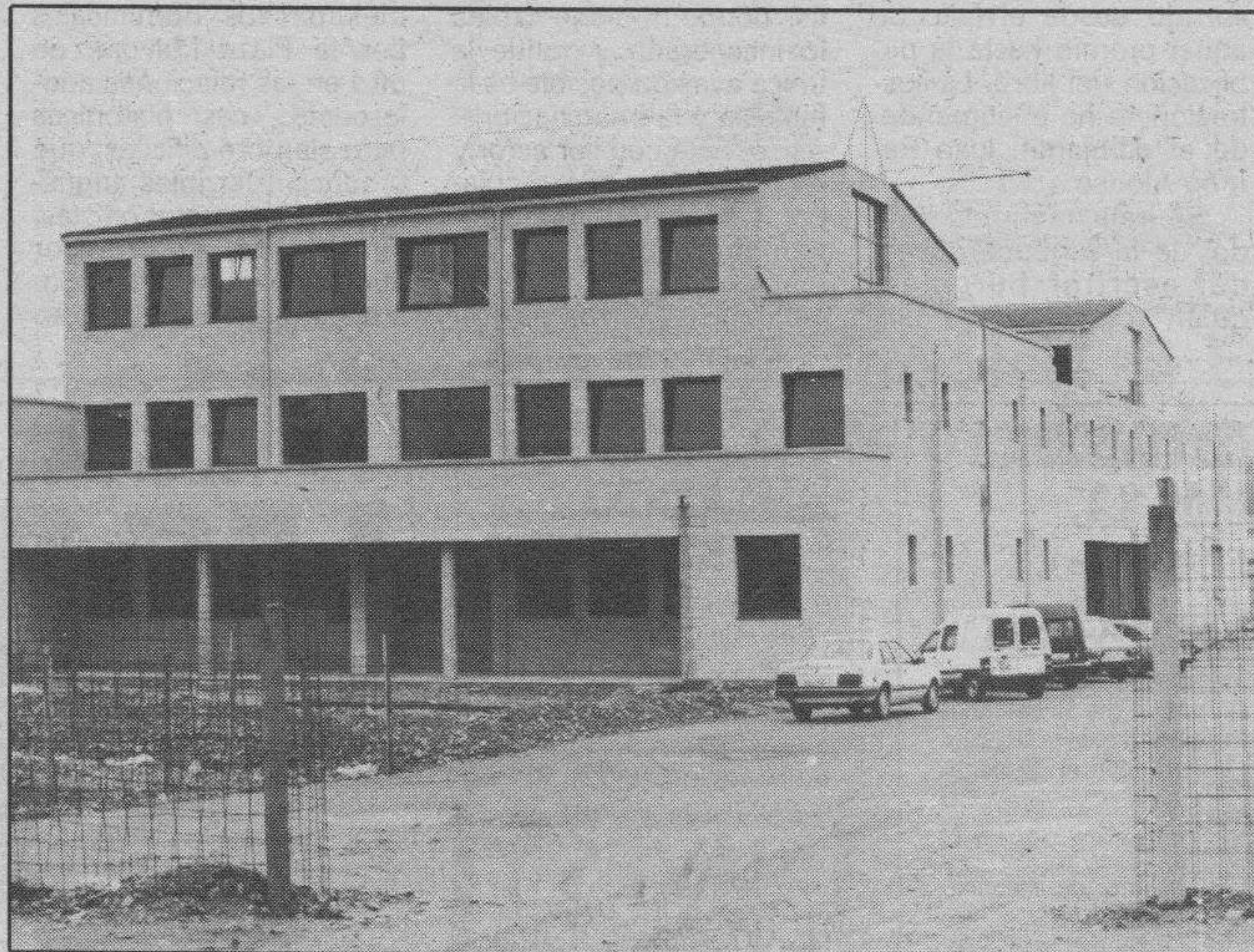
Edificio en construcción correspondiente al proyecto «Enebro», de Cáritas.
