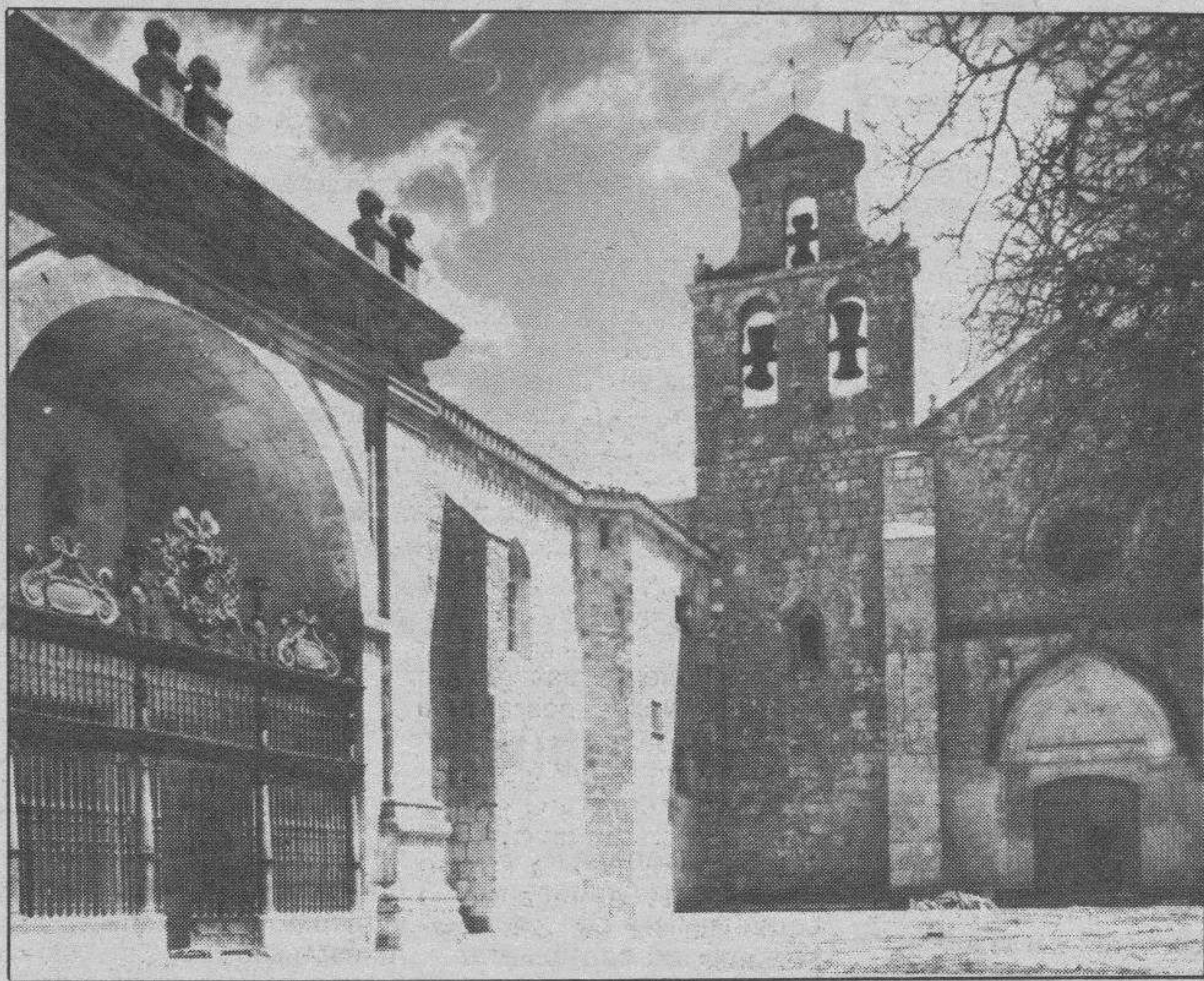
Fachada principal del Monasterio de San Juan de Ortega.
