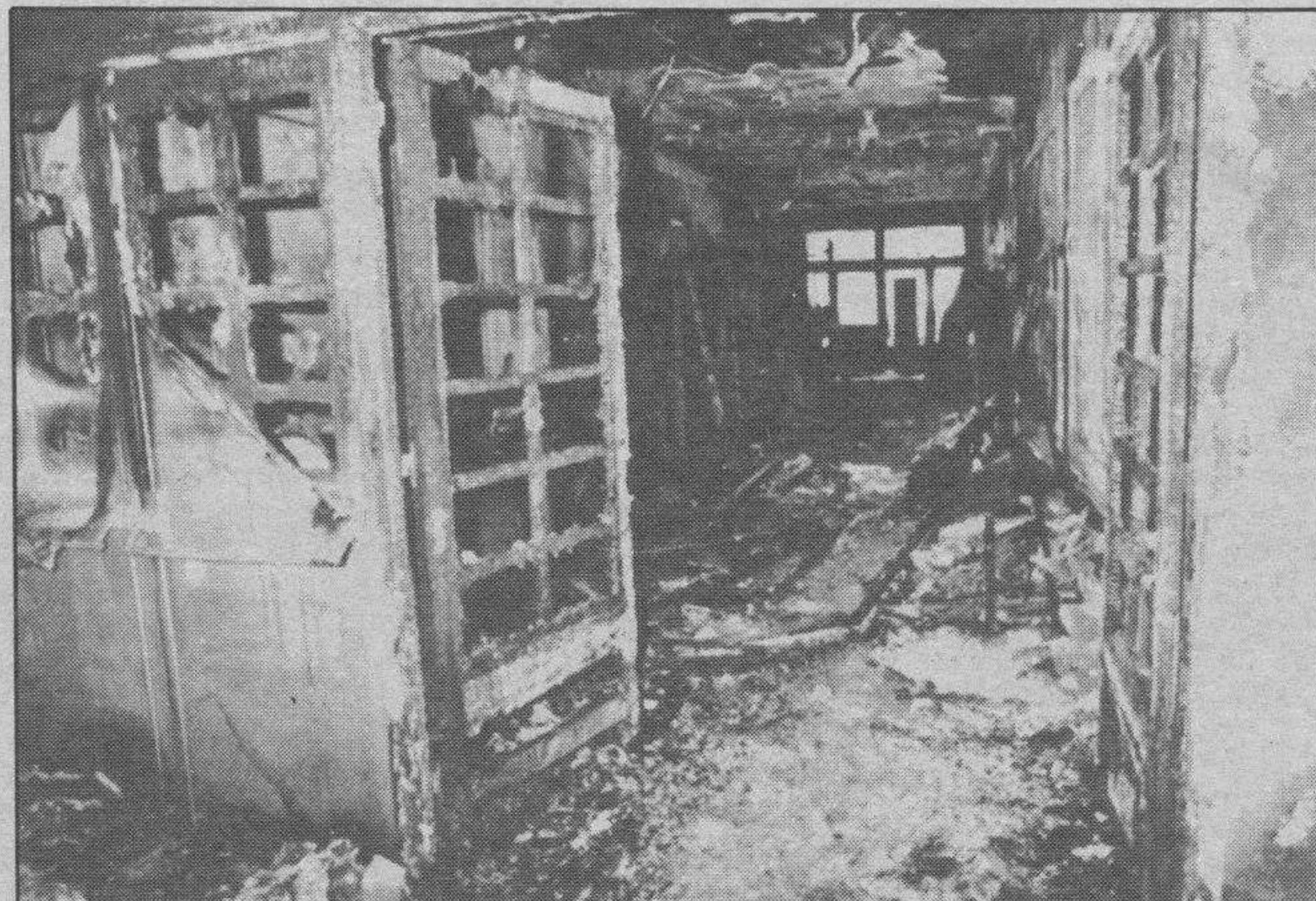
Aspecto de la salida de emergencia del Ayala tras el incendio. Efe
