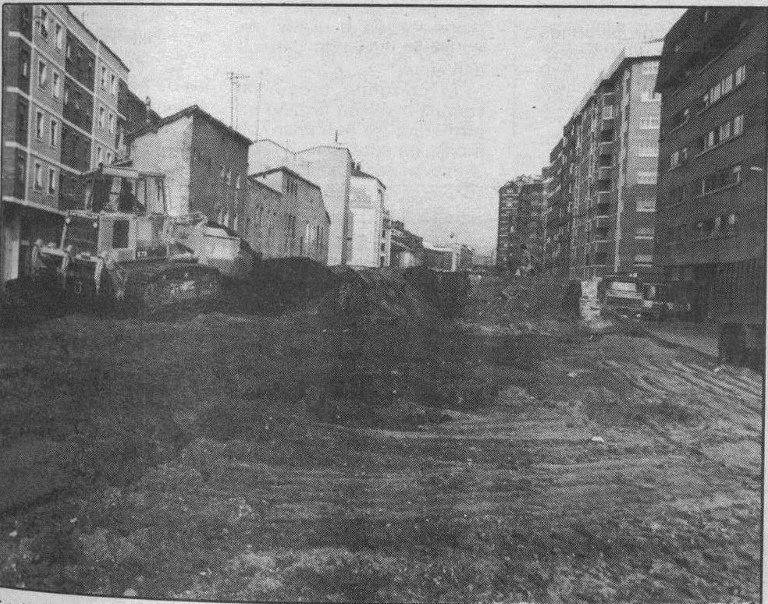
Estado de la C/. Ronda del Ferrocarril tras el desmontaje del puente de Ocaña. Foto Truchuelo.
