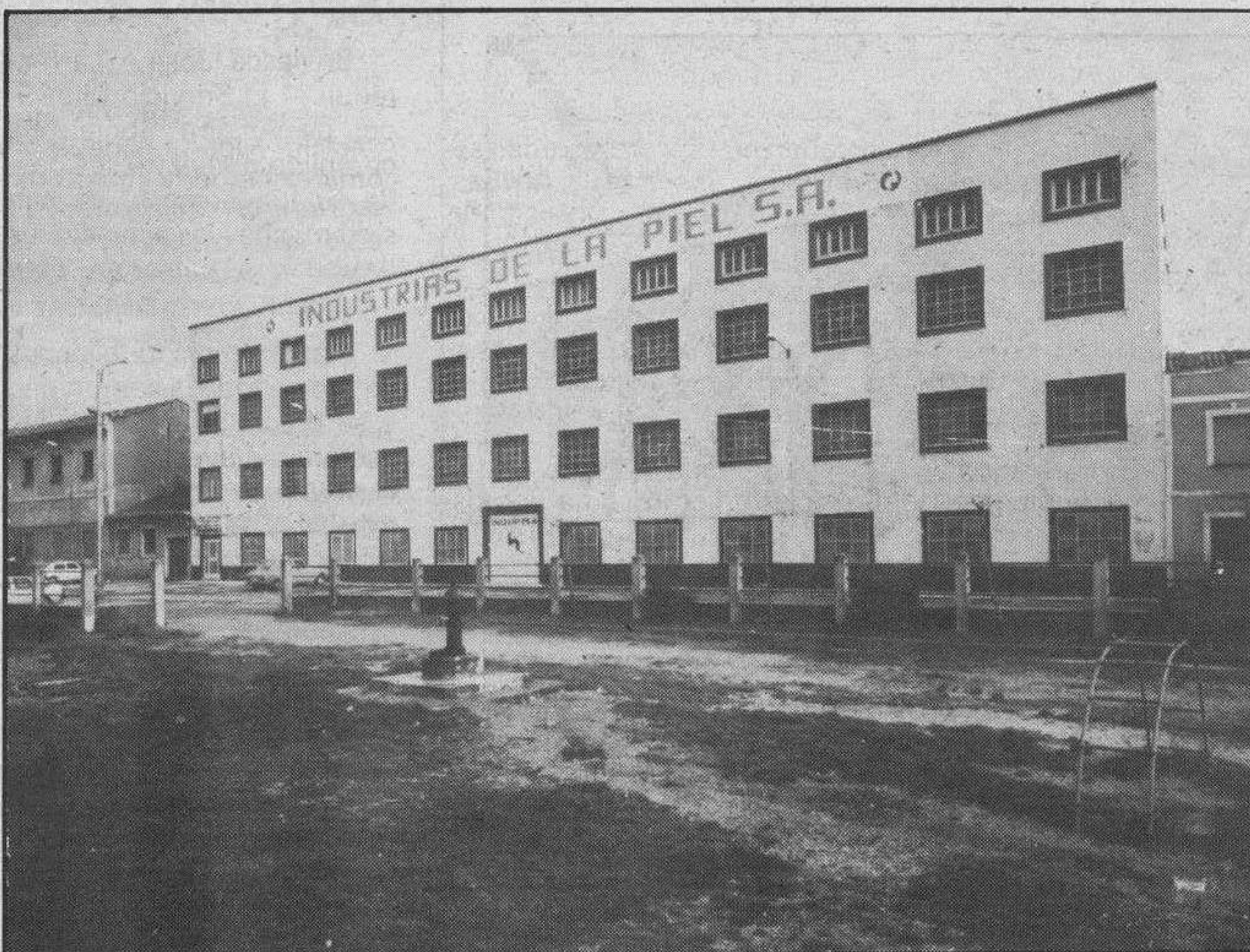
Exterior de Indupisa, situada en la zona de Capiscol.
