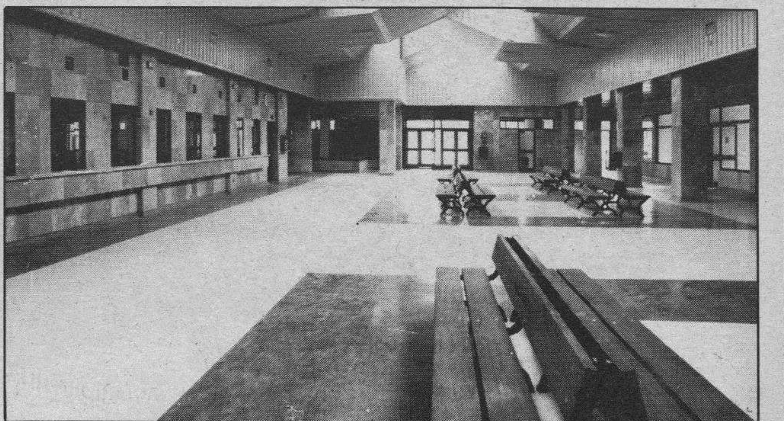
Interior estación de autobuses.— Foto Lara.
