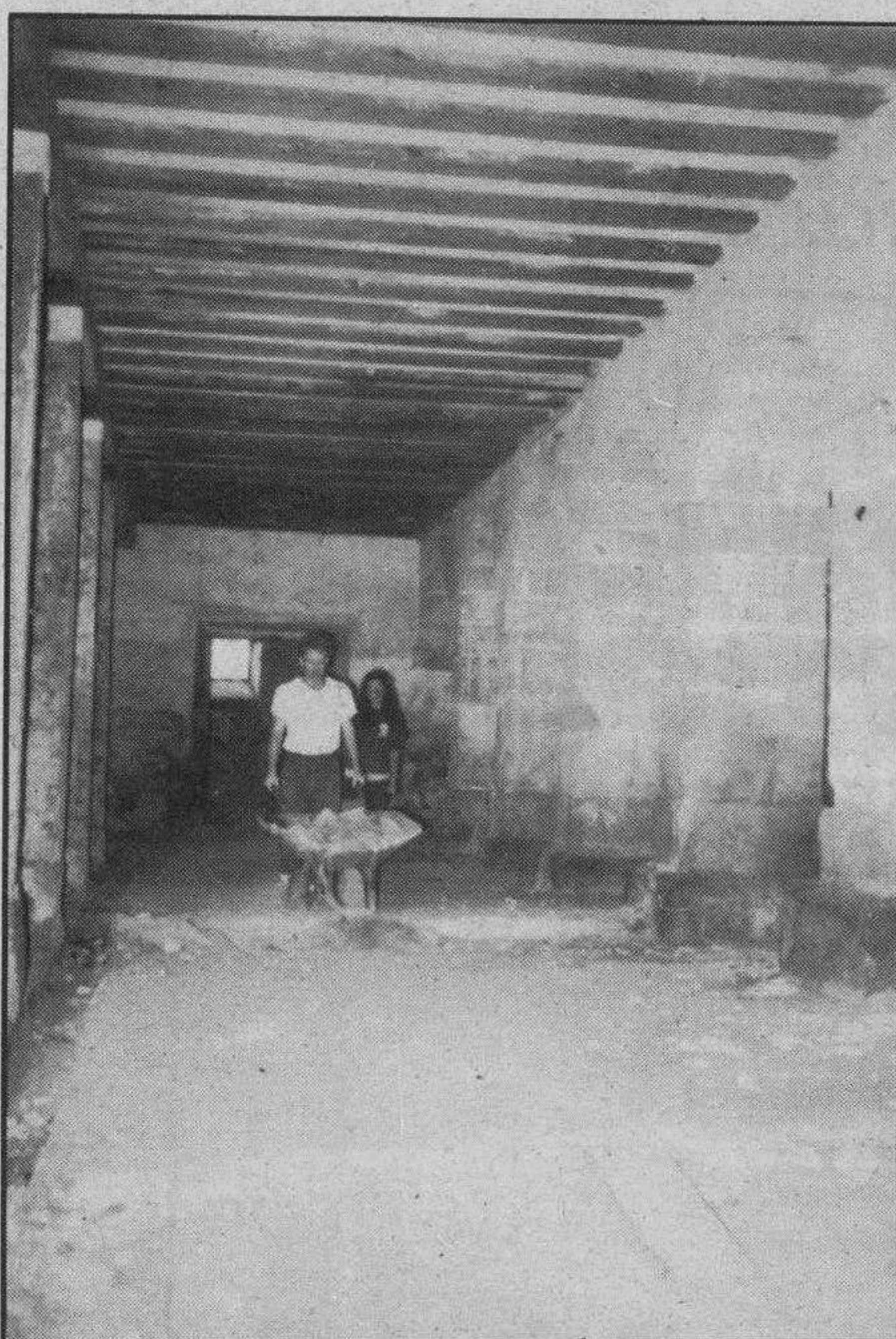
Trabajos de acondicionamiento en el edificio.
