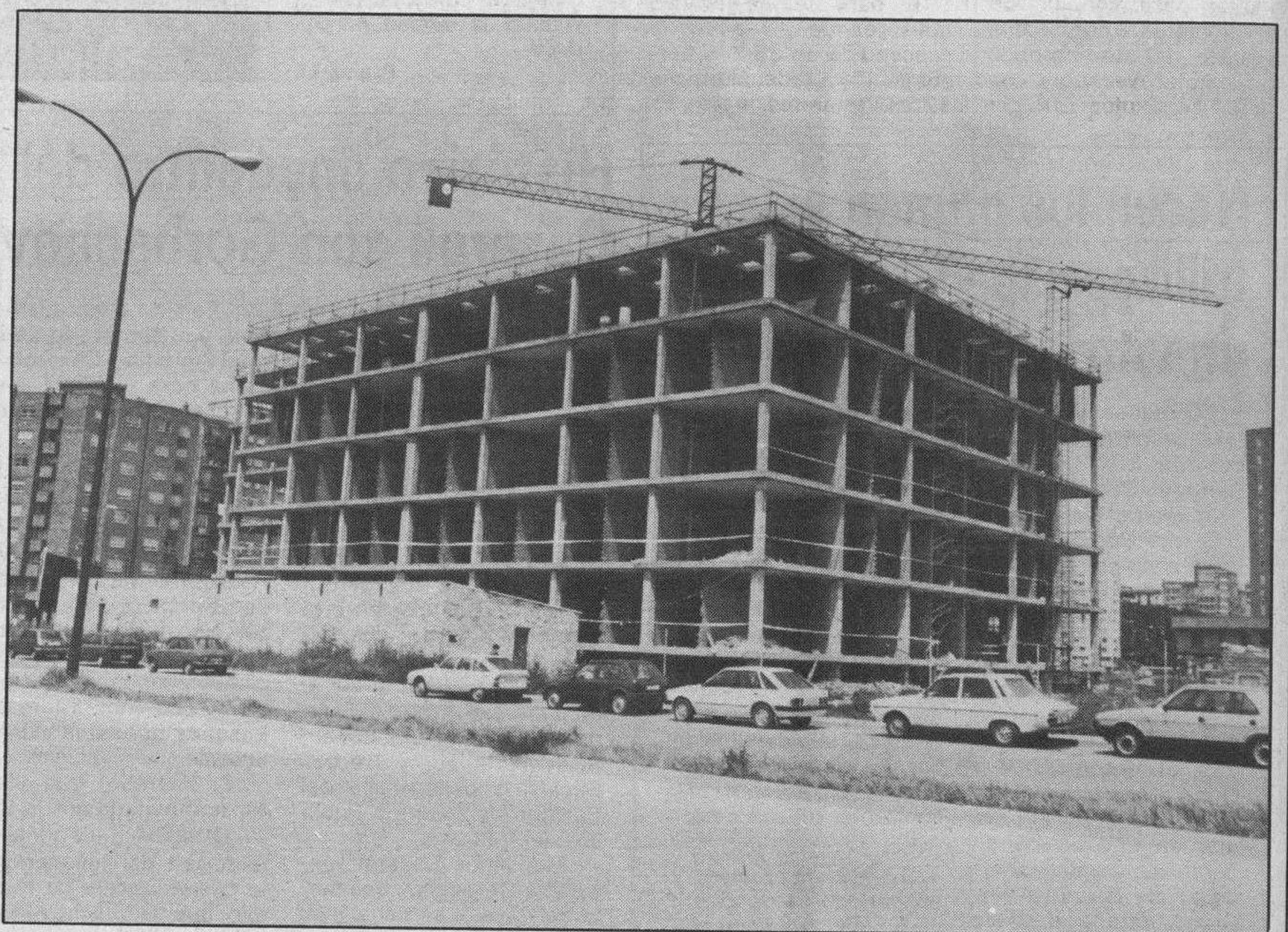
Un edificio esperado. — 'Estas son las obras de construcción del edificio de usos múltiples de la Junta de Castilla y León, una realización importante y, sobre todo, muy necesaria y esperada. La multiplicidad de organismos, la diferenciación de competencias hace que el administrado se vea con muchas dificultades a la hora de desplazarse de un lugar para otro para hacer gestiones. Eso es lo que hay que evitar, concentrando servicios en una sede y dando a conocer, claramente, las competencias de las Administraciones.
