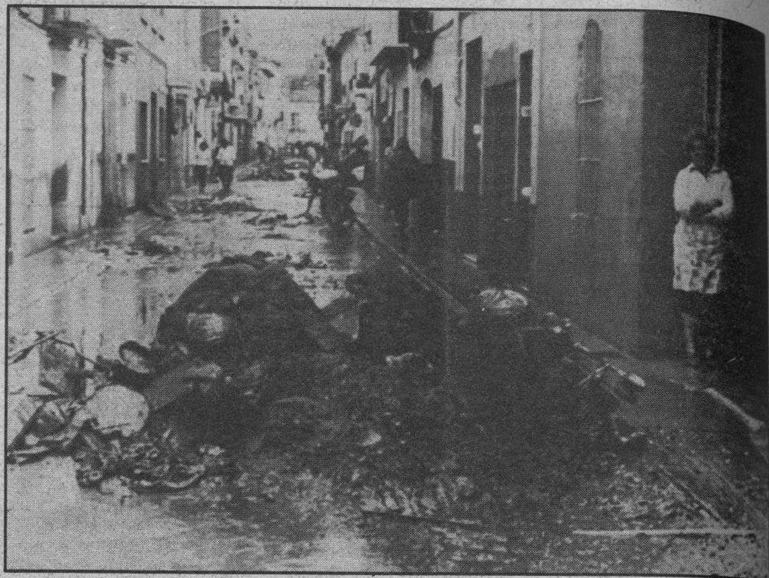
Daños causados por la avenida en una calle de Gandía (Valencia). — Foto archivo.
