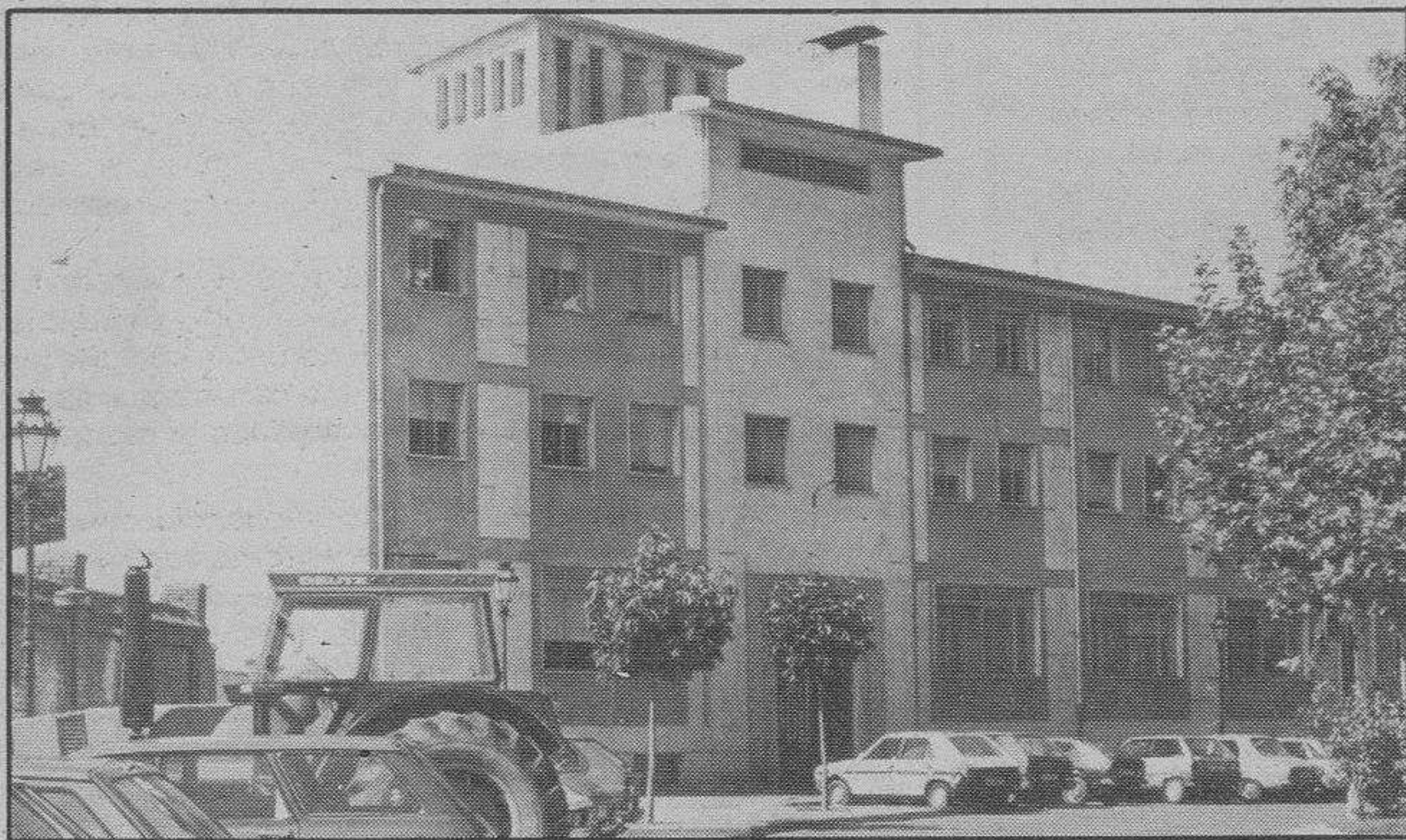
El Arzobispado llevará a cabo obras de reforma y acondicionamiento en la residencia sacerdotal
