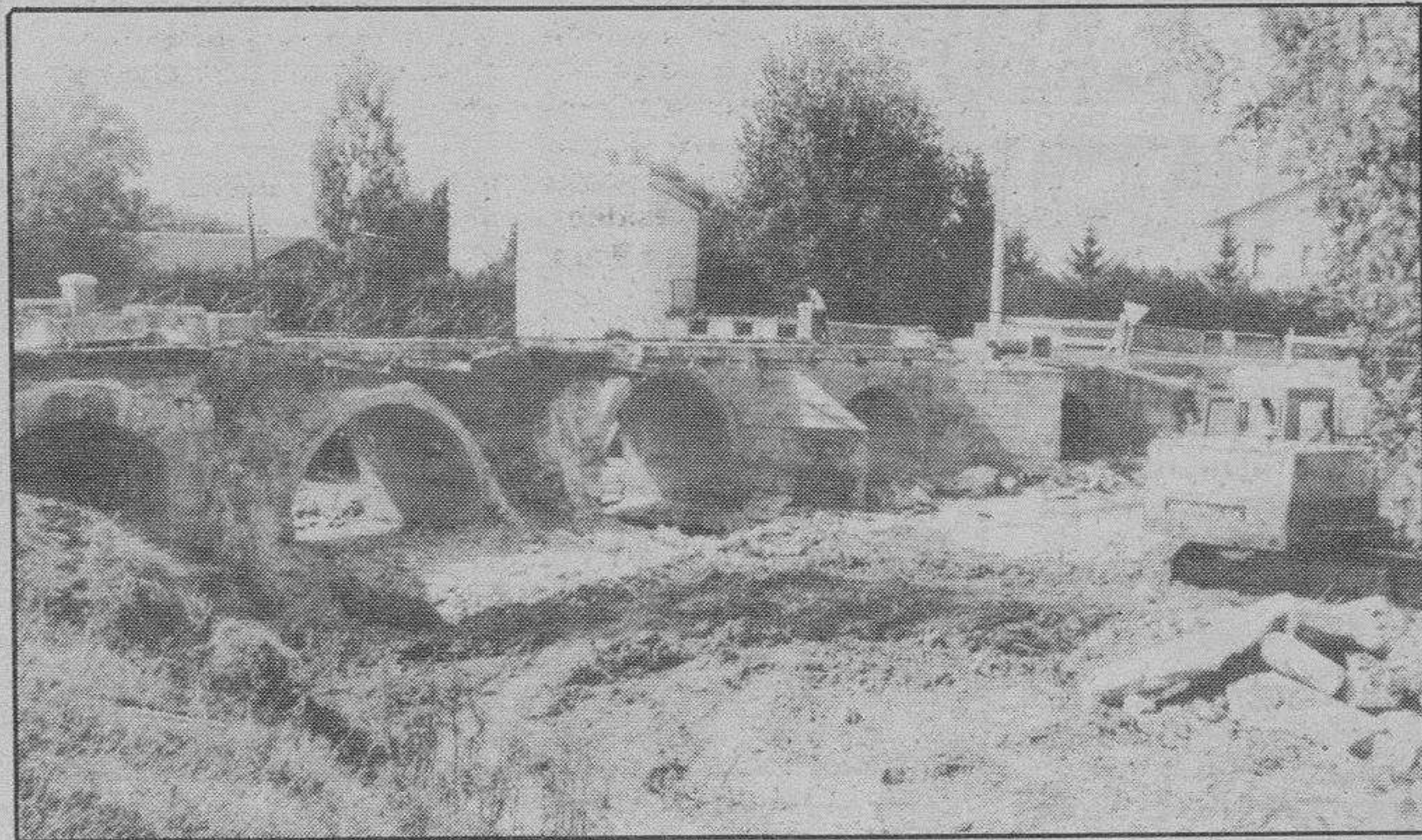
Ampliación del puente de «La Curiela» en Villadiego.
