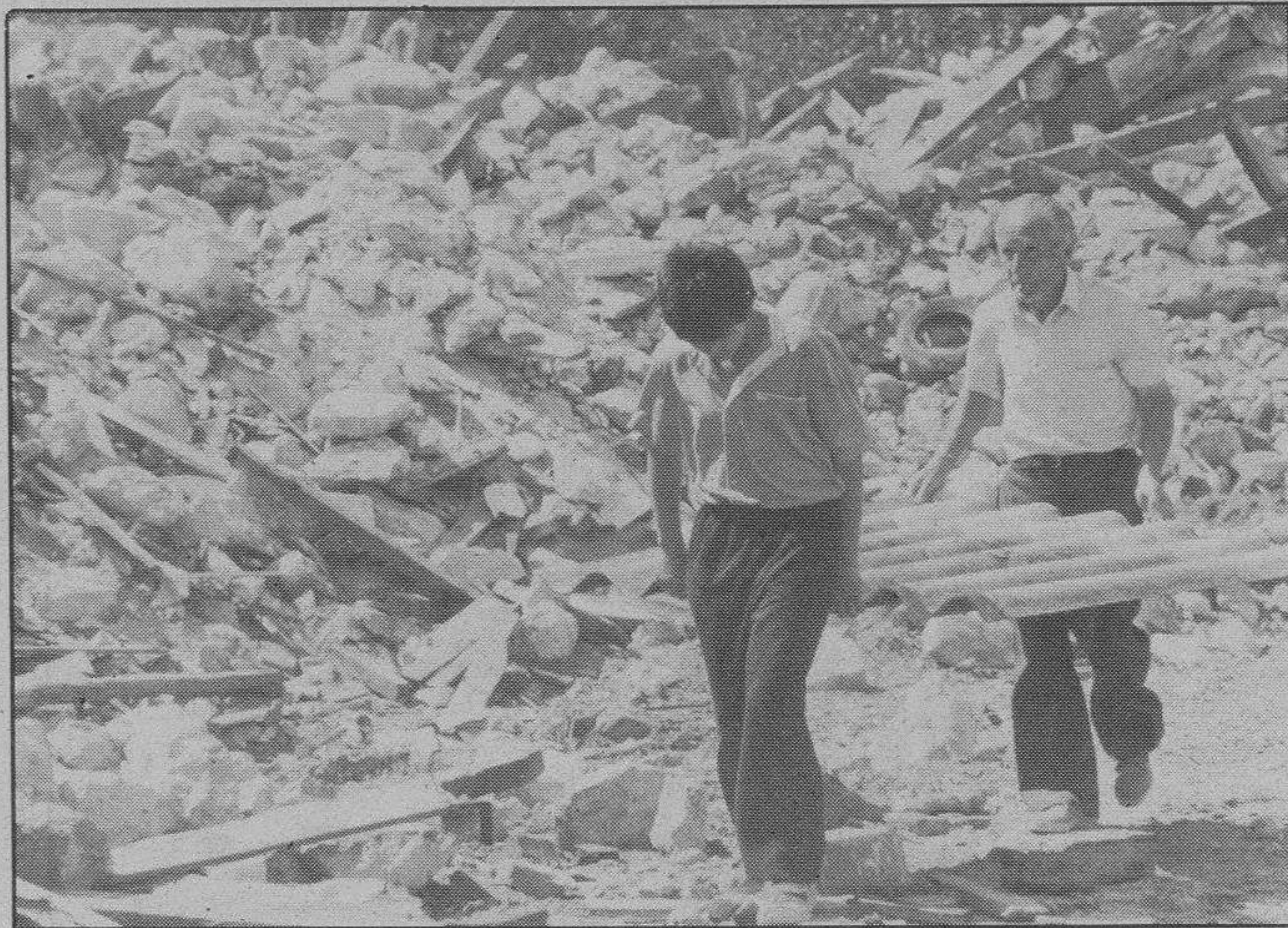
Vecinos intentan recuperar utensilios de los escombros. Foto Florentino Lara.
