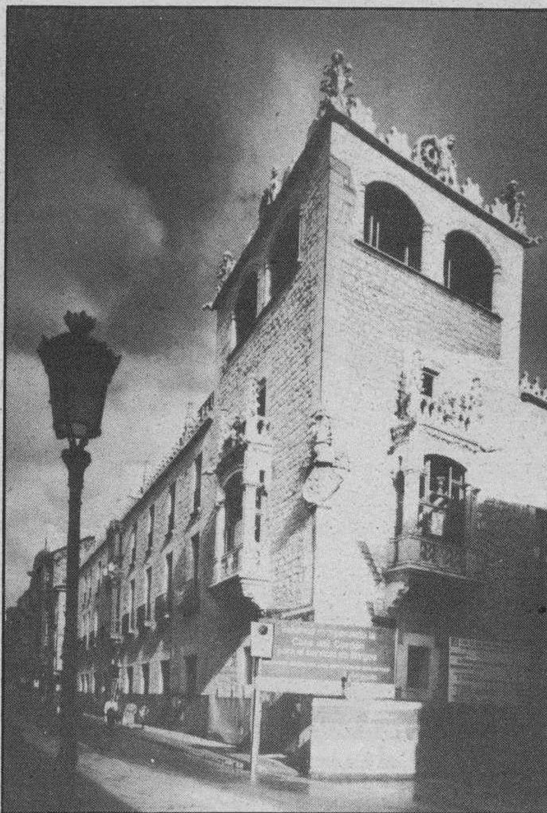
He aquí una de las vistas parciales de la restaurada Casa del Cordón.
