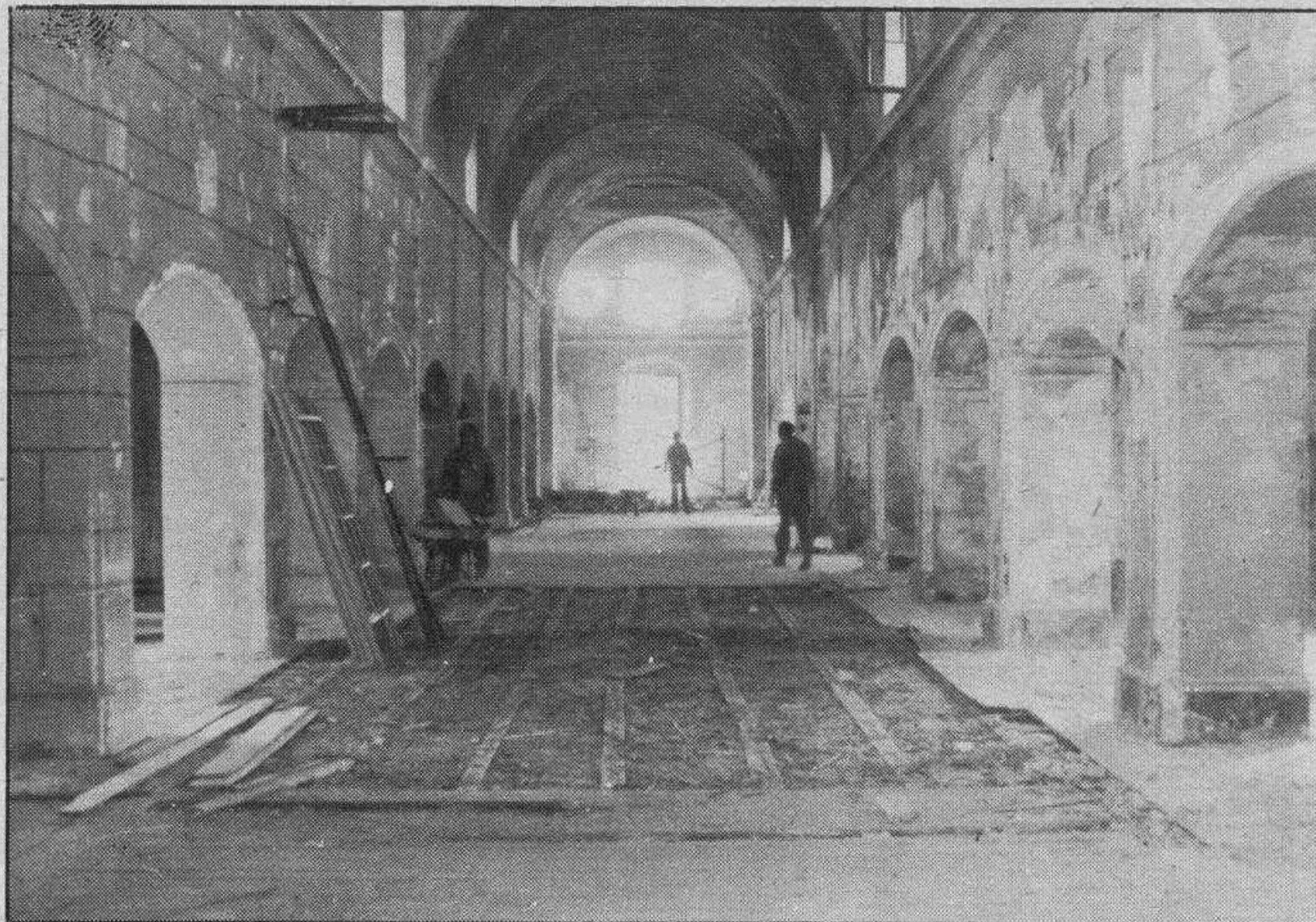
La actualidad del Hospital del Rey adquiere plena vigencia con la concesión de la licencia de obras de la primera fase.
