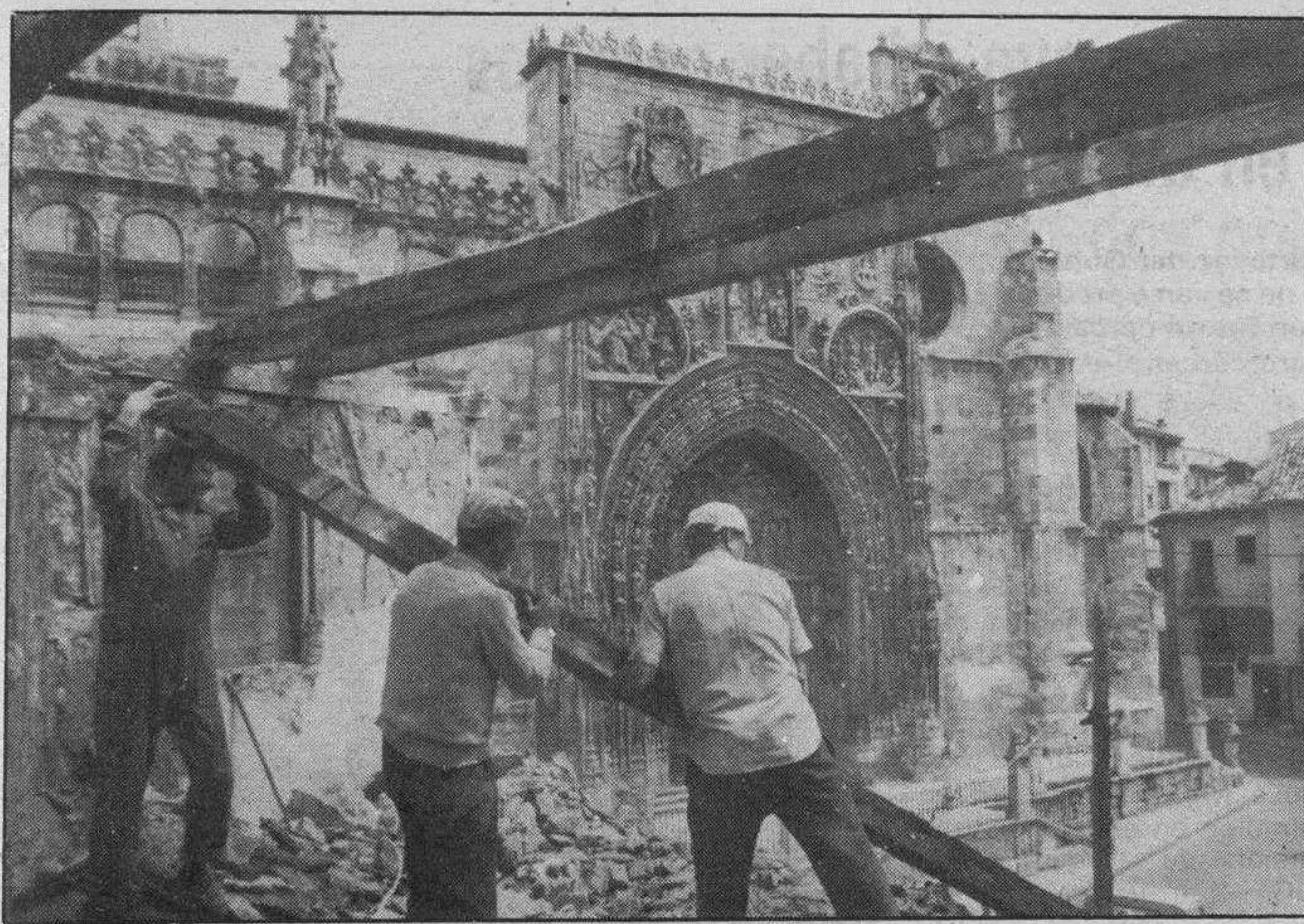
Obras de derribo de la «Casa de los Curas» para su posterior edificación. Foto Lara.
