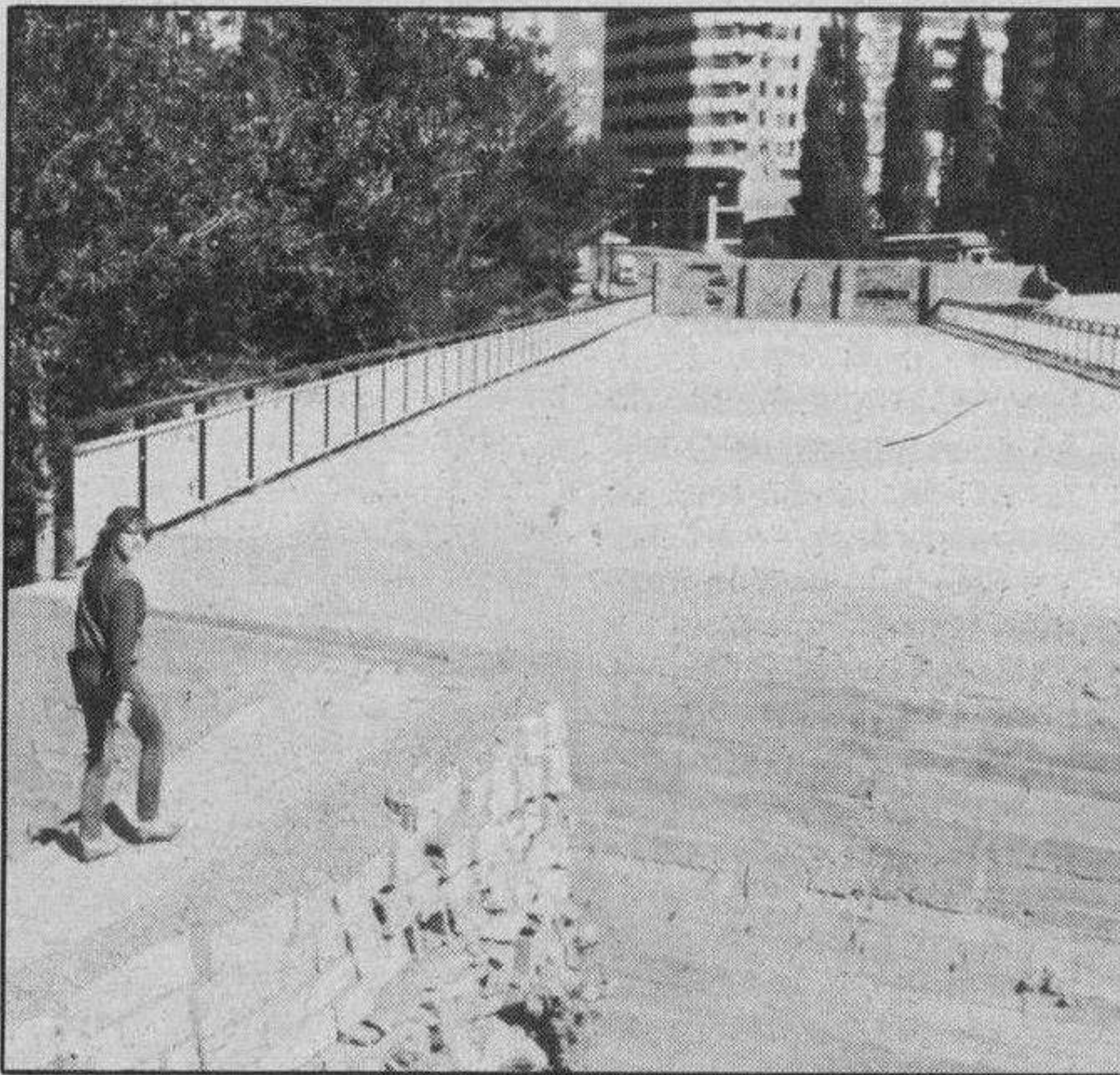
Puente de Bigar, cuyas obras de acondicionamiento comenzarán en breve. F. Lara.
