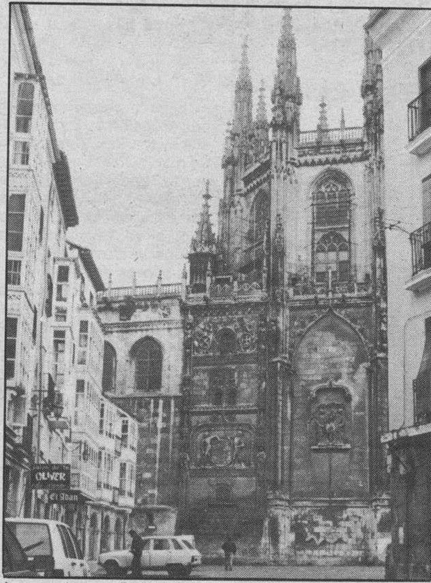
Ayuntamiento y Patrimonio han llegado a un acuerdo. La pavimentación de la Llana de Afuera se completará
